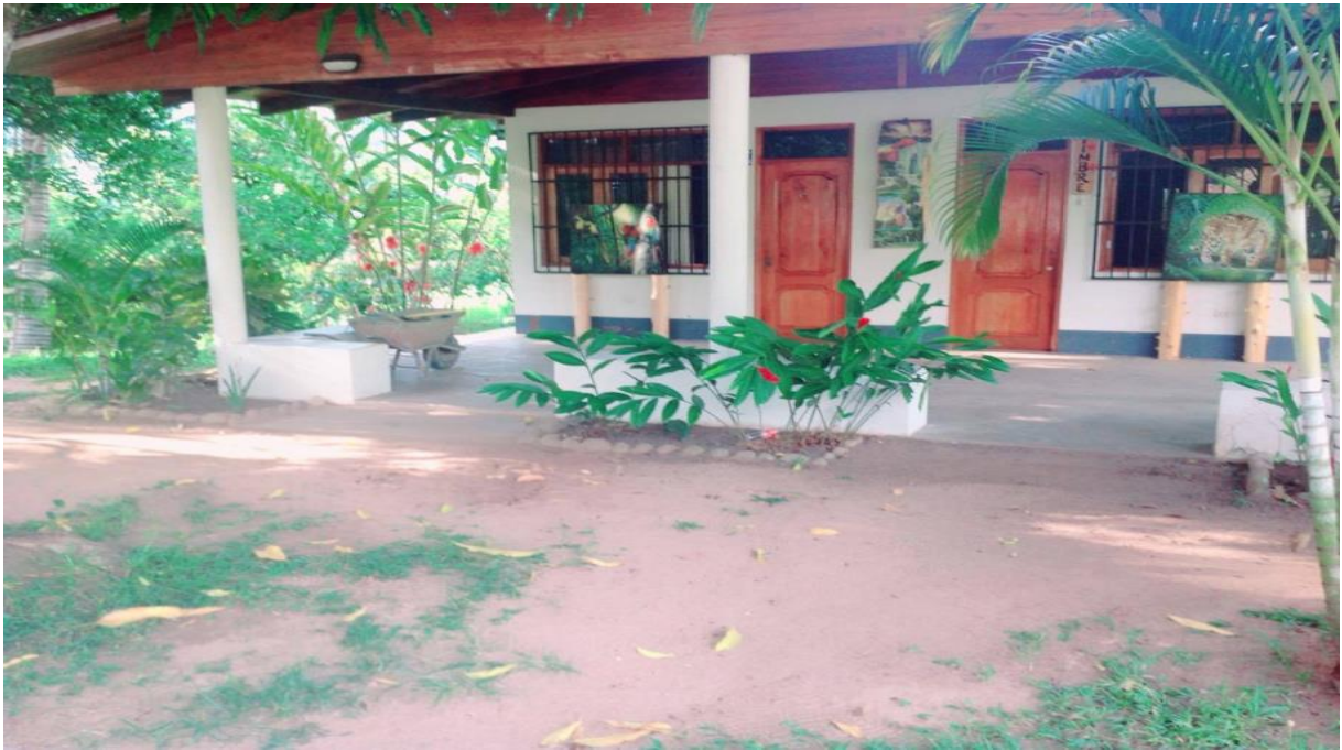
Fotografía 7. Salón de recepción “El Tinkuy”. Fuente propia.
