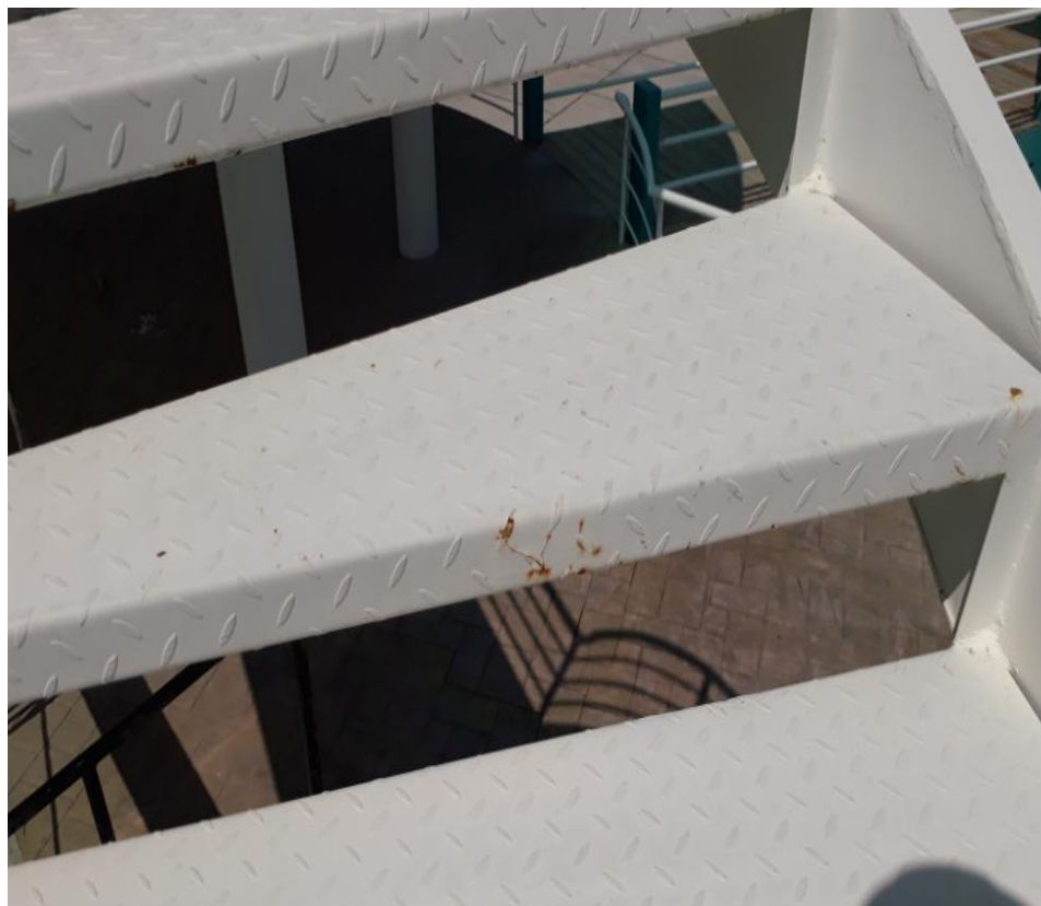
Fig. N° 08 Oxidación
