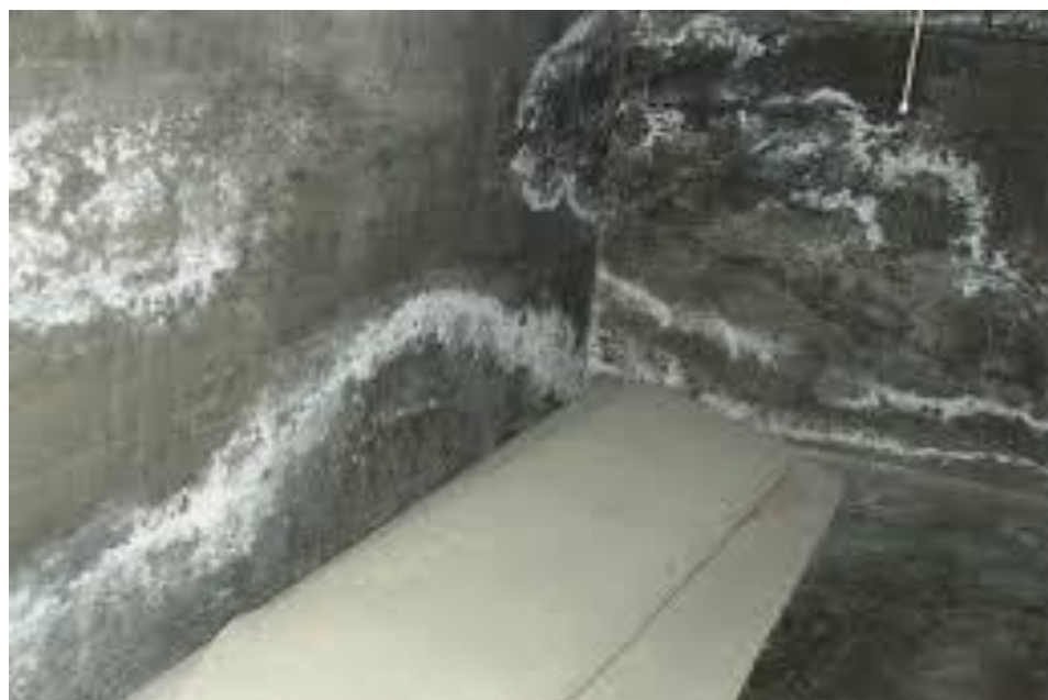
Fig. N°10 Eflorescenciaorrosión
