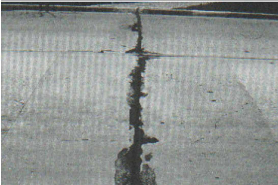
Figura 2.12: Esquema de falla denominada "fisura inducida.
