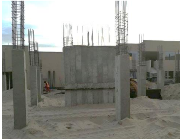
Gráfico 5: estructuras de concreto armado.
