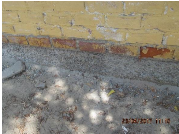
Gráfico 11: Erosión física en el sobrecimiento.
