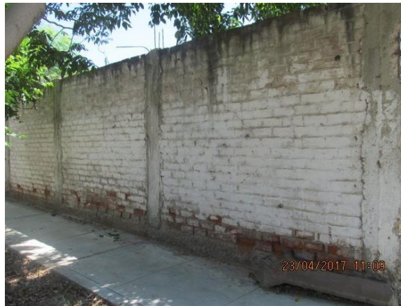
Gráfico 10: suciedad afectando en un tercio del elemento.
