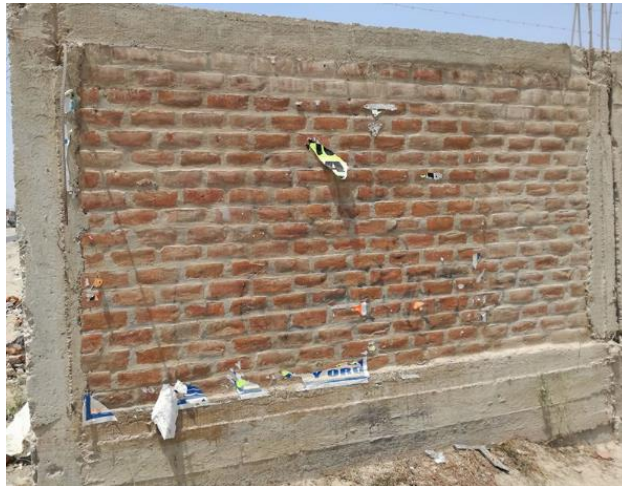
Gráfico 6: Elementos de confinamiento.
