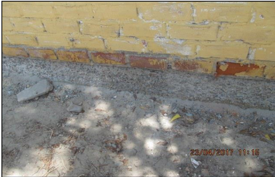
Gráfico 50: Presencia de erosión en el sobrecimiento perteneciente a la unidad de muestra 5.
