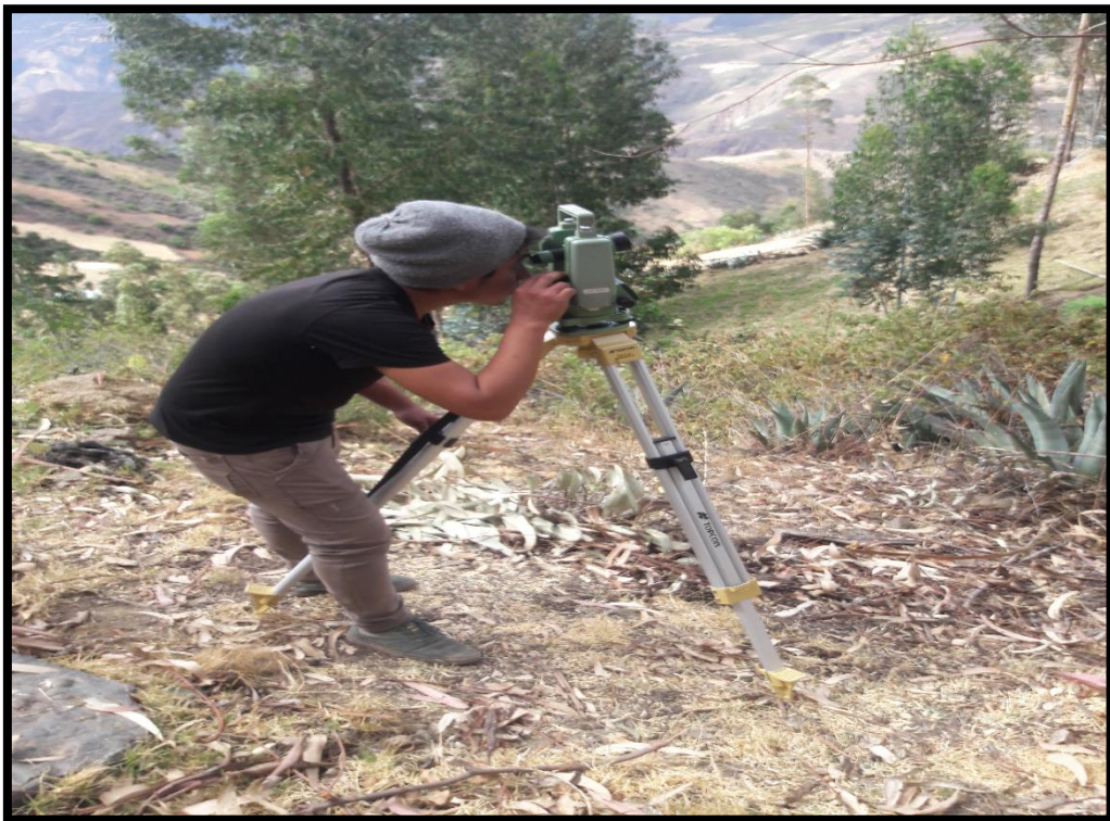
Imagen 24. Levantamiento topográfico en la línea de conducción tramo 1
