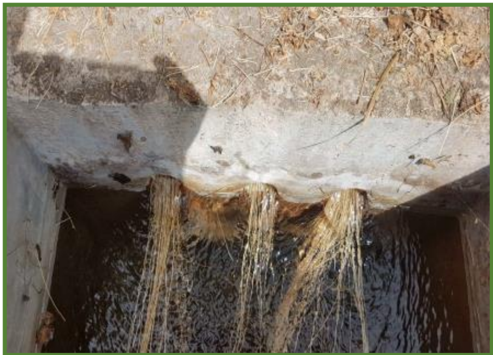
Imagen 02. Cámara húmeda de la captación
