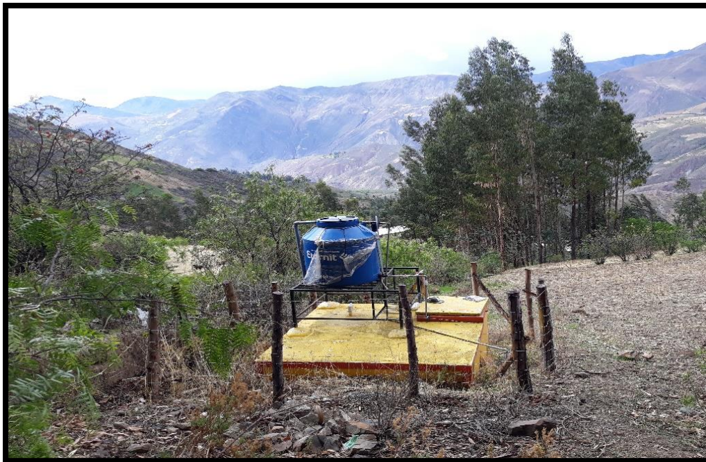
Imagen 20. Reservorio de almacenamiento del caserío Nueva Esperanza
