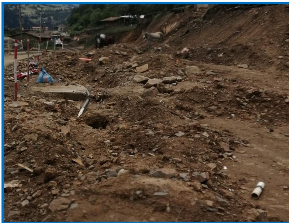
Imagen 09. Red de distribución expuesta a la intemperie (tubería principal)
