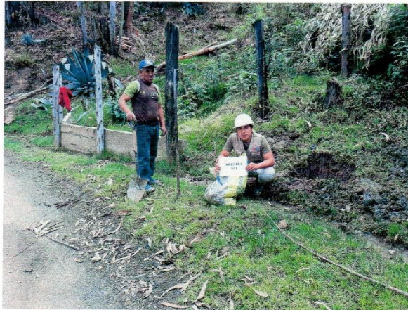
VISTA DE CALICATA Nº 1 - CAPTACIÓN HUAYCHAO
