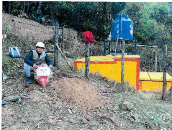
VISTA DE CALICATA Nº 2 - RESERVÓRIO
