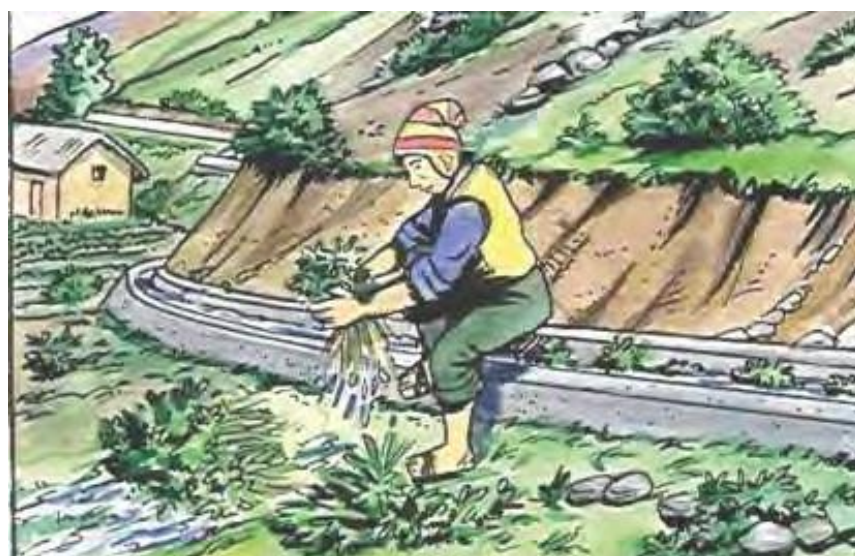
Figura 20. Daño al canal de riego por colmatación. Fuente: Ministerio de agricultura y riego – 2015.
