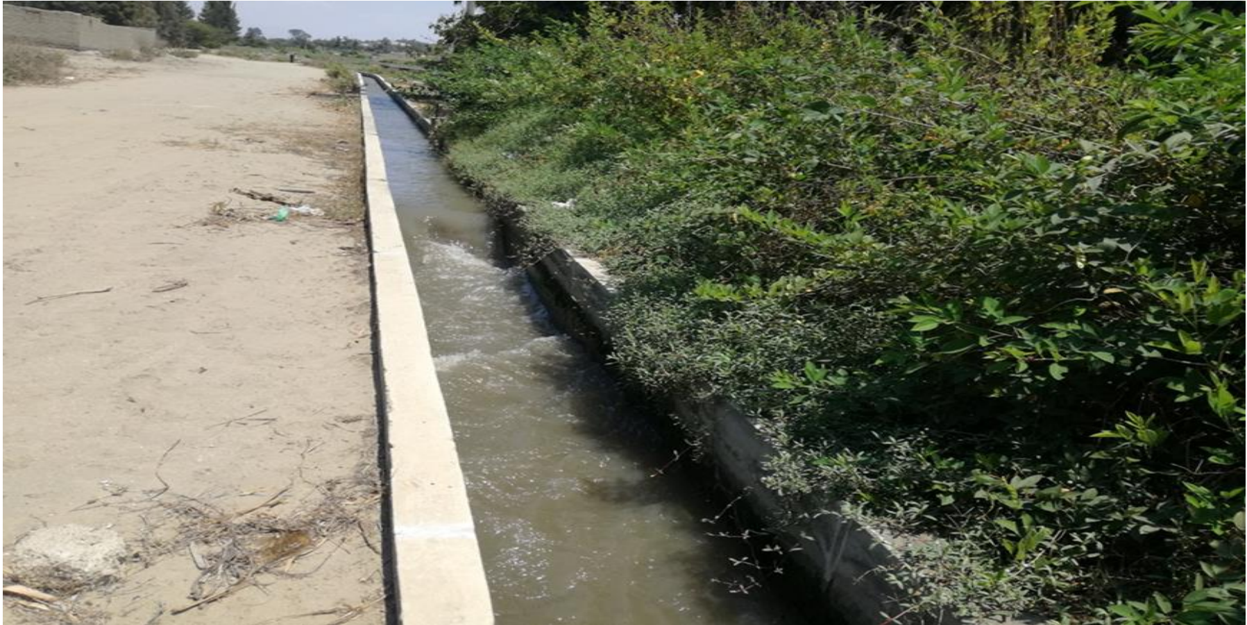
Figura 128. Foto panorámica del canal sub lateral B-24
