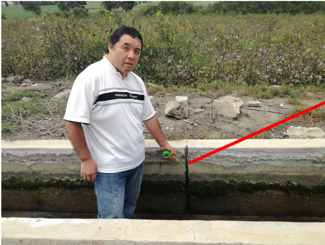
Figura 135. Daño por sello de junta, ubicado en la unidad de muestra 02.
