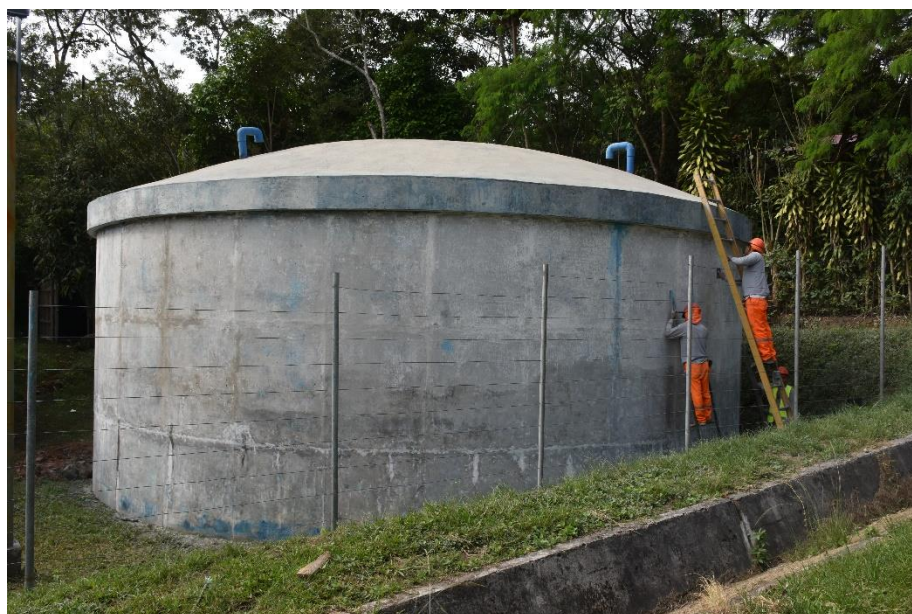
Figura 2. Reservorio R1 – San Mateo – Moyobamba. Fuente: Inco Perú – 2019.
