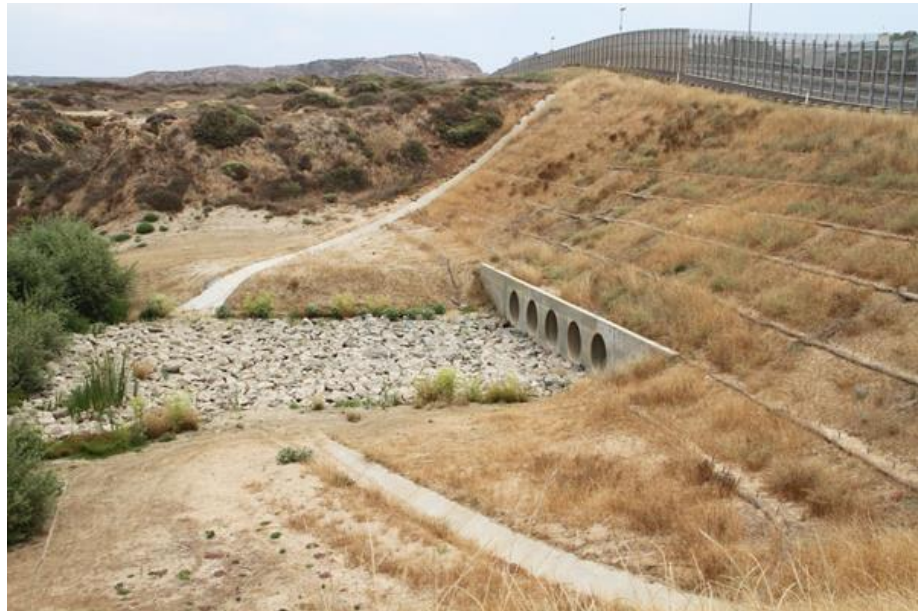
Figura 7. Alcantarilla del Cañón Yogurt – Frontera México y Estados Unidos. Fuente: Ponce – 2008.
