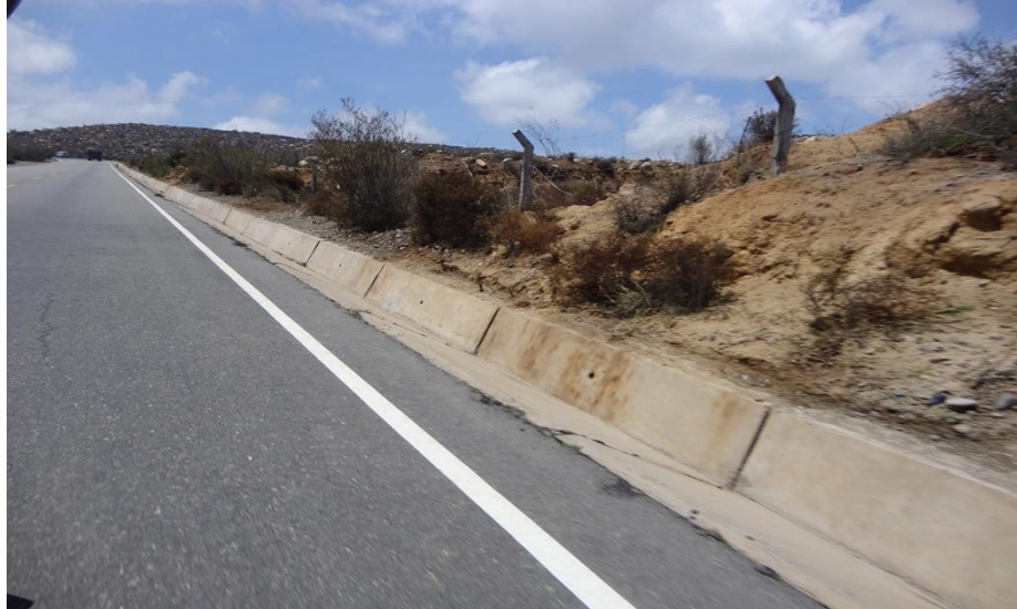
Figura 3. Cuneta revestida de concreto.
