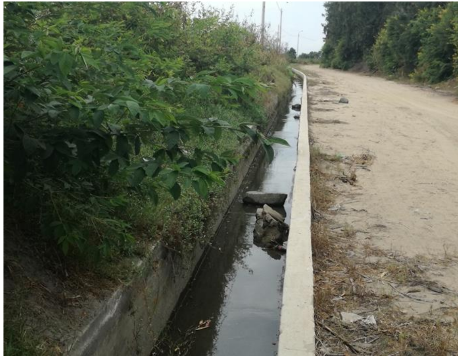
Figura 26. Vegetación en el canal sub lateral B-24. Fuente: Elaboración propia – 2020.
