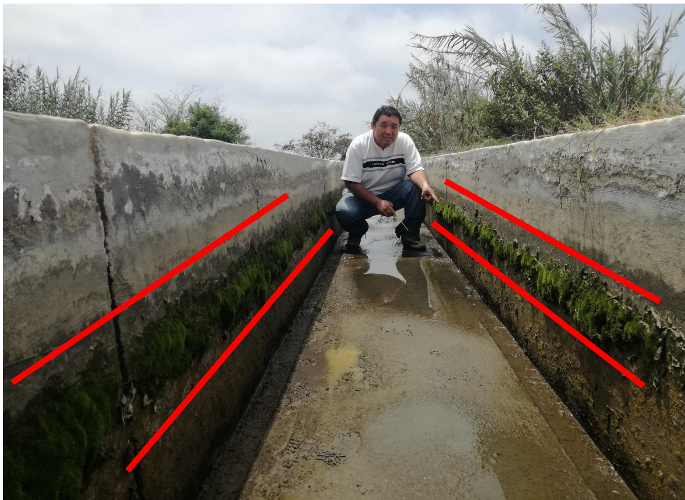
Figura 134. Daño por musgo, ubicado en la unidad de muestra 17. Fuente: Elaboración propia – 2020.
