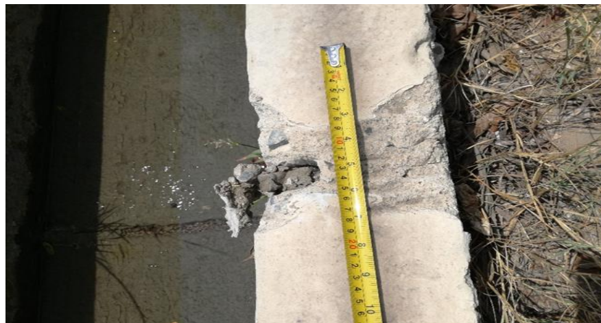
Figura 24. Impacto en el borde del canal sub lateral B-24. Fuente: Elaboración propia – 2020.
