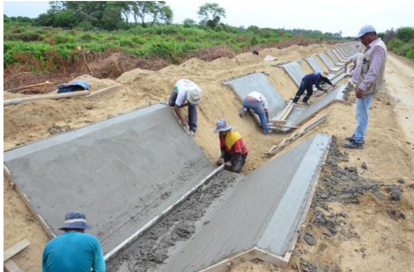
Figura 15. Recubrimiento de mortero. Fuente: Rufino G. – 2010.
