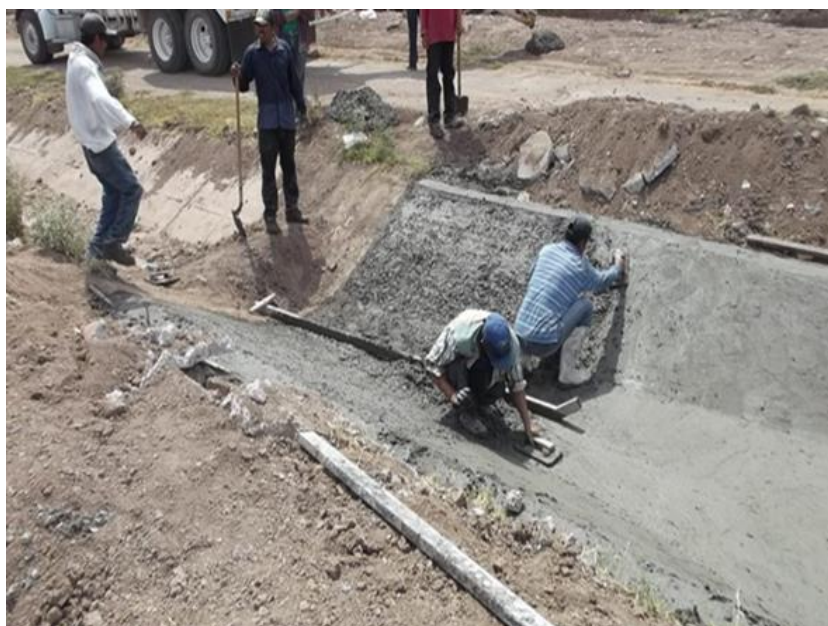
Figura 14. Revestimiento de concreto. Fuente: Meza L. – 2014.
