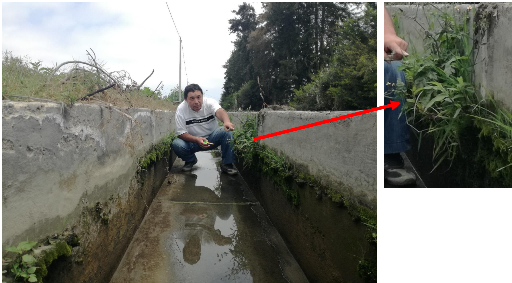
Figura 131. Daño por vegetación, ubicada en la unidad de muestra 07.
