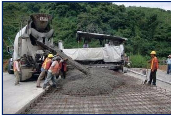
**Figura 26:** Concreto Premezclado.
