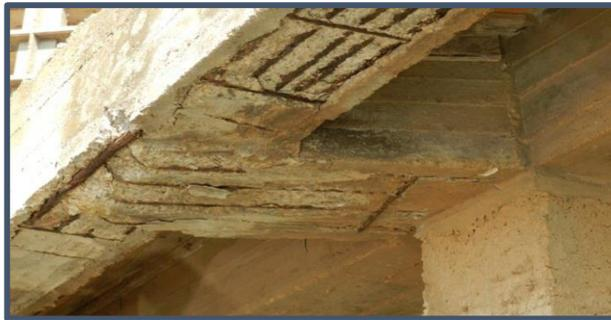
**Figura 38:** Corrosión en las armaduras de la viga de concreto armado.
