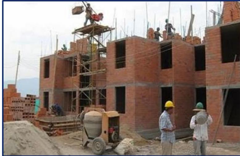
**Figura 9:** Construcción de una vivienda de albañilería confinada.
