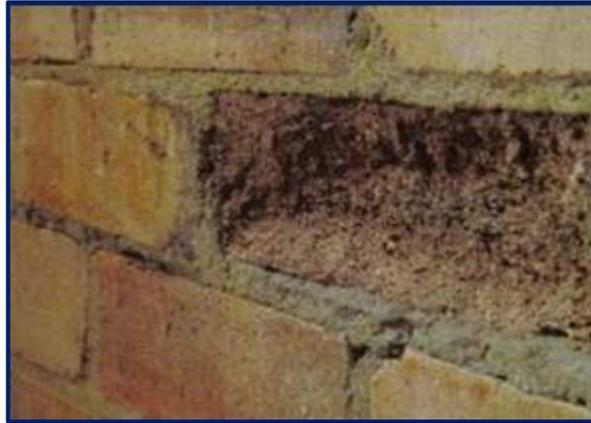
**Figura 45:** Erosión Física En Muro.
