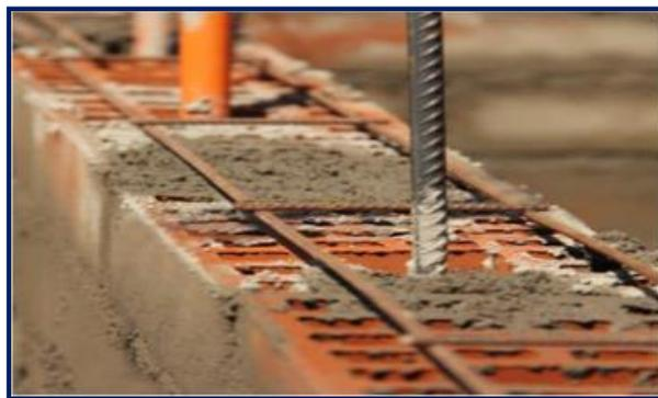
**Figura 7:** Albañilería Armada.
