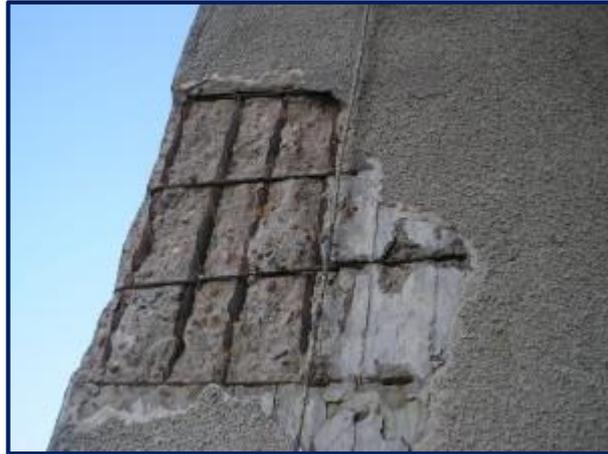
**Figura 51:** Corrosión del acero.
