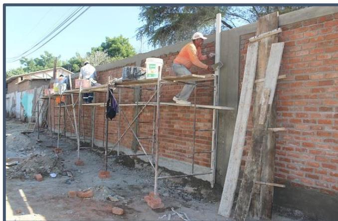
**Figura 14:** Proceso constructivo de un cerco perimétrico de albañilería confinada usando columnas de amarre.
