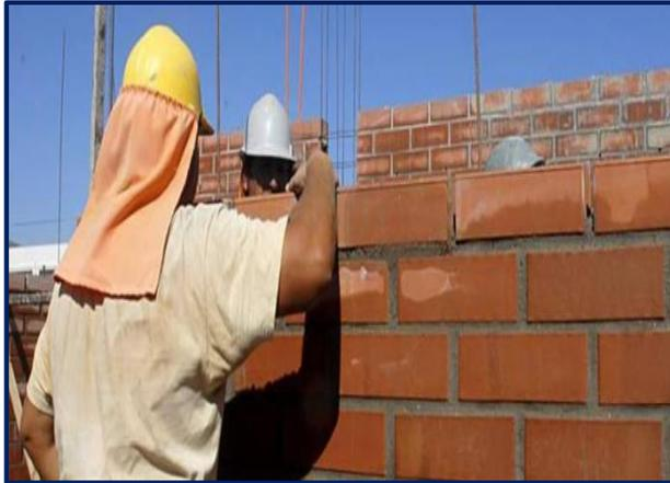
**Figura 16:** Muro de albañilería confinada.
