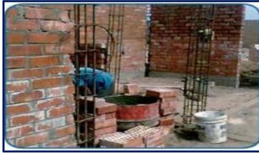
**Figura 5:** Proceso constructivo de un muro de albañilería.
