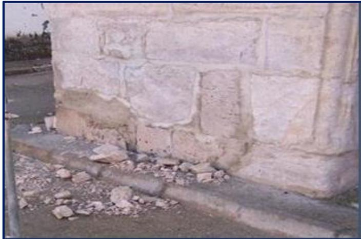
**Figura 47:** Desprendimiento del concreto de una pared.
