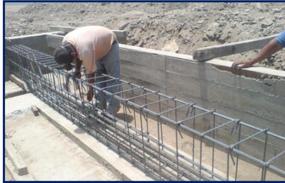
**Figura 33:** Viga de concreto armado.
