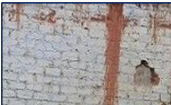
**Figura 49:** Erosión mecánica.
