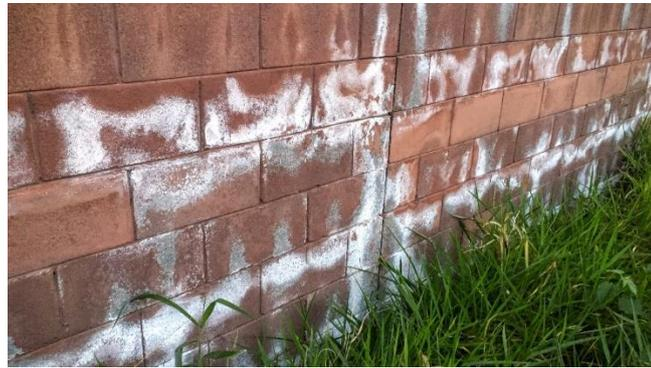
**Figura 50:** Eflorescencias en muro.
