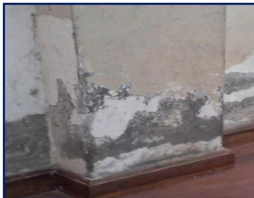
**Figura 37:** Eflorescencia en columnas.
