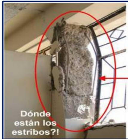
**Figura 36:** Compresión en la columna por falta de estribos.
