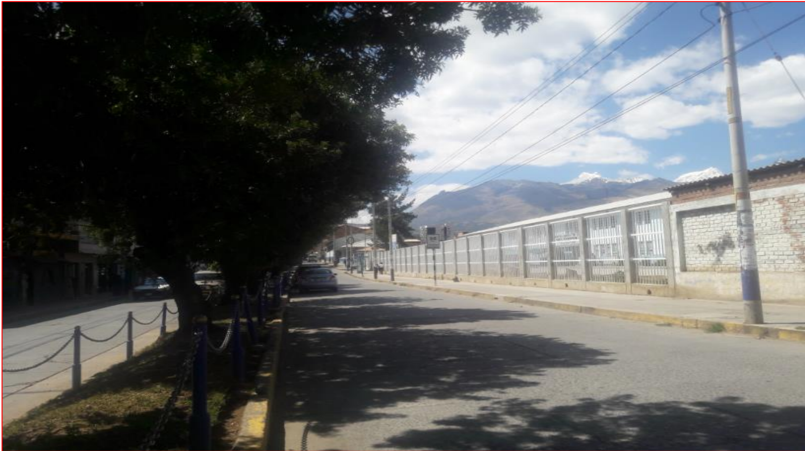
Vista de Cerco Perimétrico del hospital Víctor Ramos Guardia Lado Oeste - Av. Luzuriaga
