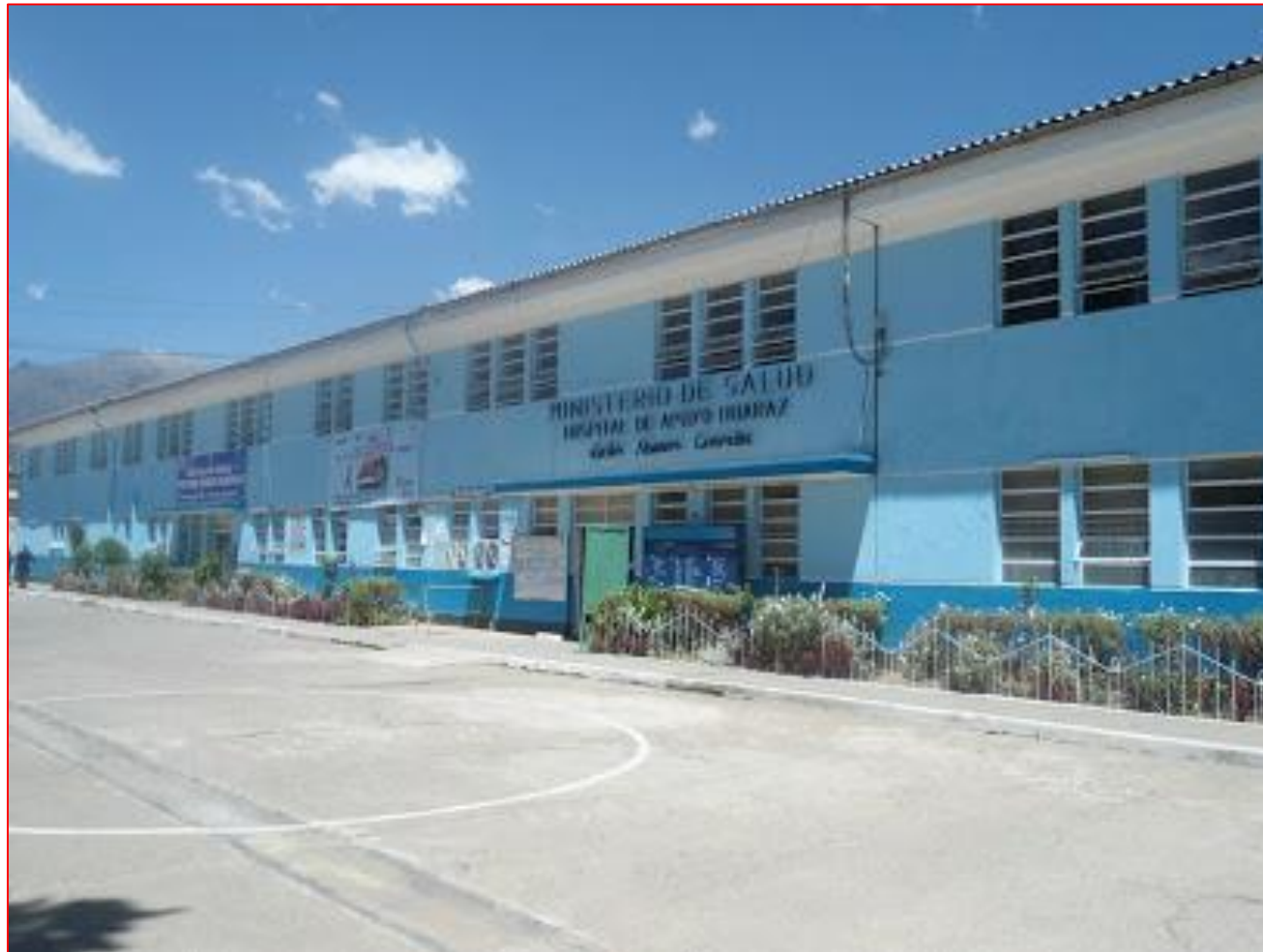
Vista fachada hospital Víctor Ramos Guardia de Huaraz
