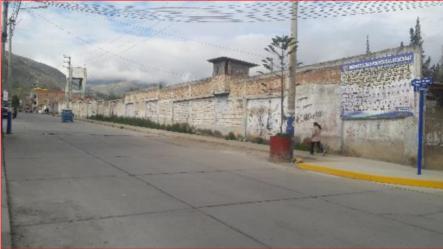
Vista de Cerco Perimétrico del hospital Víctor Ramos Guardia Lado Este - Jr. Simón Bolívar
