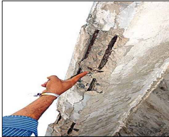
Figura 14: Corrosión
