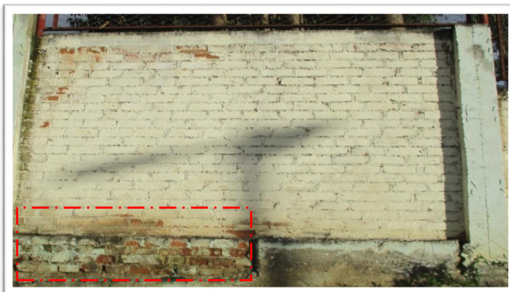
Determinación de heladicidad en la UM 04 de la losa deportiva de Tarica
