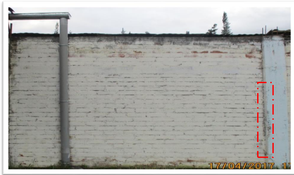
Determinación de desintegración en la UM 06 de la losa deportiva de Tarica
