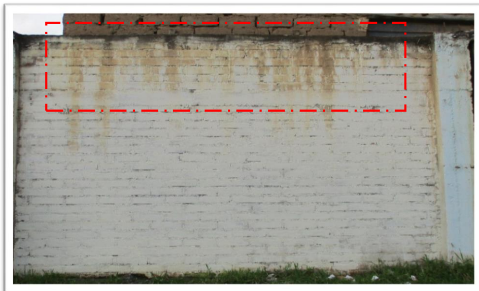
Determinación de manchas en la UM 06 de la losa deportiva de Tarica
