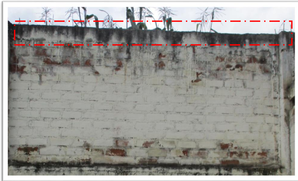
Determinación de mohos en la UM 05 de la losa deportiva de Tarica
