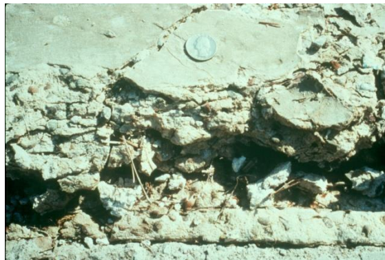
Figura 12: Desintegración
