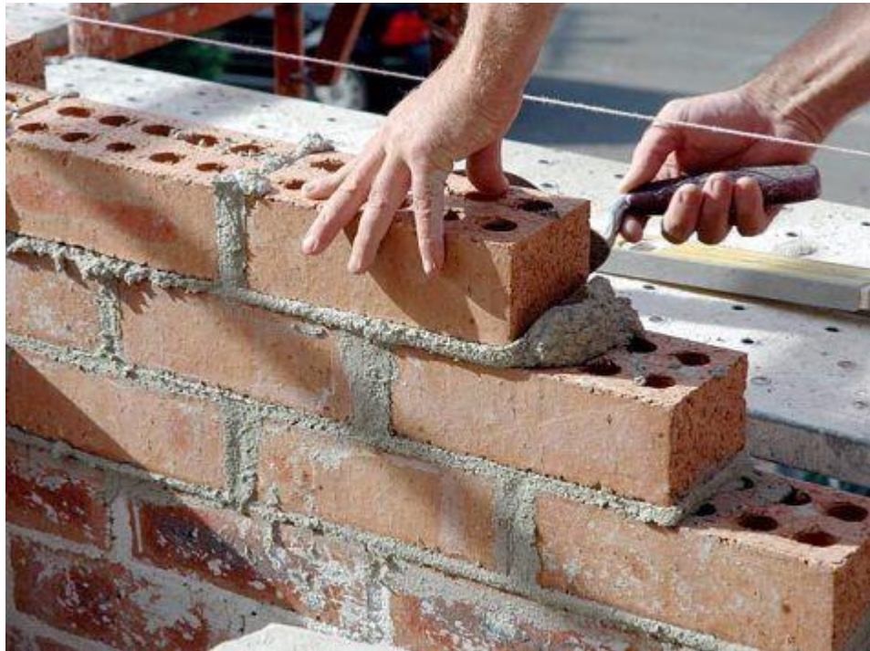
Figura 04: Muro de ladrillo
