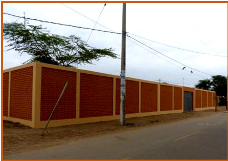
Imagen 13: Cerco Perimétrico de un colegio.
