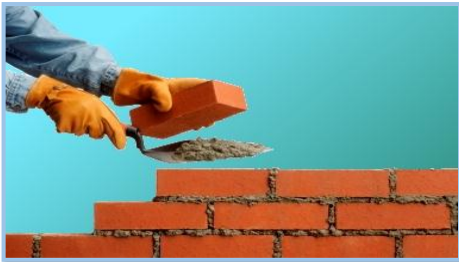
Imagen 01: Muro de albañilería o mampostería.
