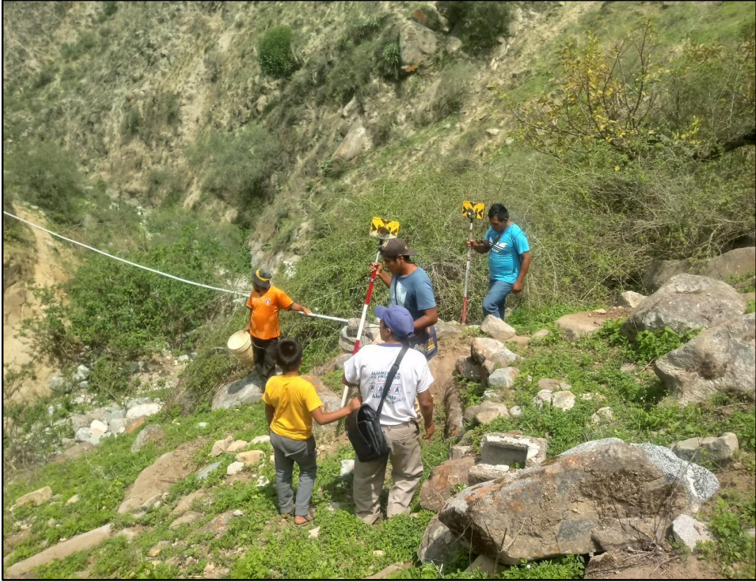
Imagen 18: Línea de conducción existente
