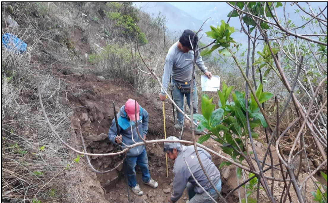
Imagen 23: Realización de la Calicata N a 02
