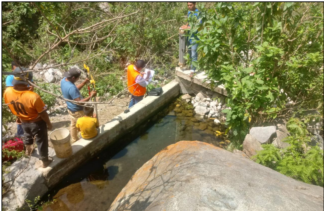
Imagen 17: Toma de puntos topográfico en la captación Mallqui
