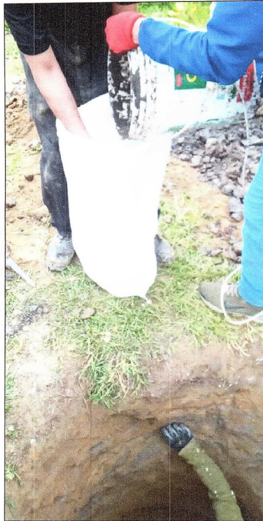
Foto N° 03.- En la toma se extrac la muestra de la Calicata C-01.
