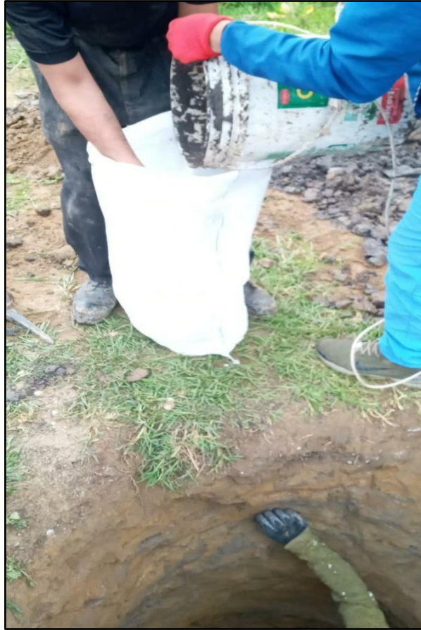
Imagen 22: Realización de la Calicata N a 01
