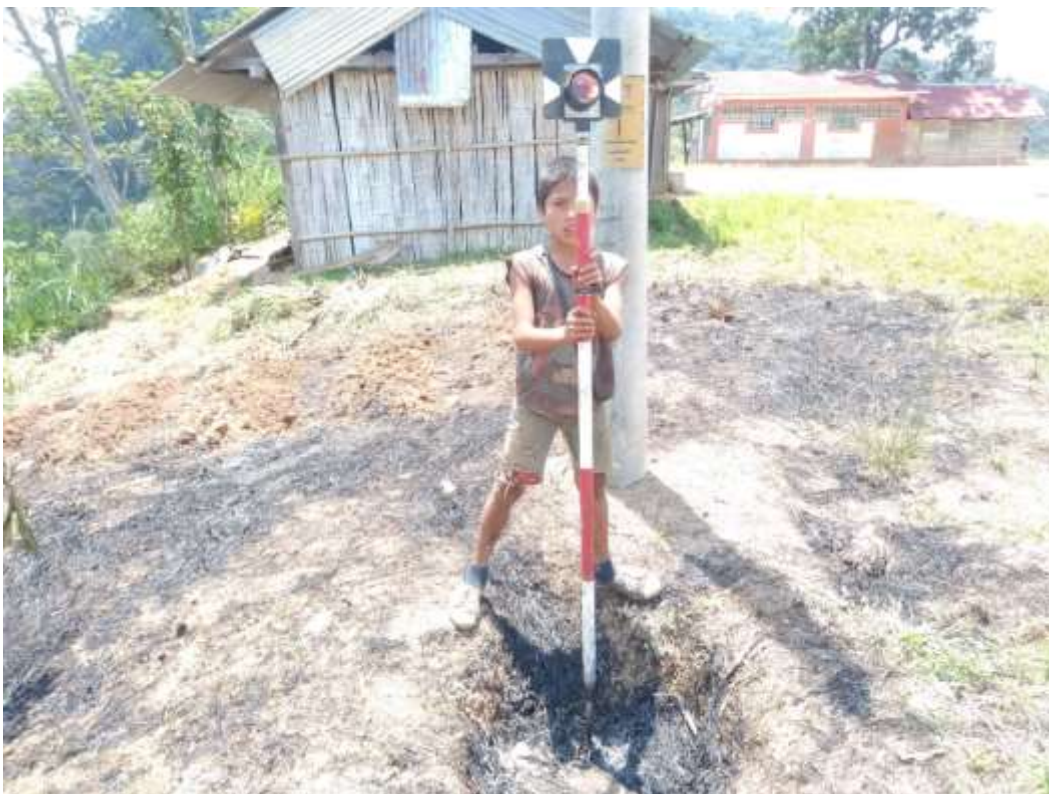
FOTO N° 4: colocación de BM.
