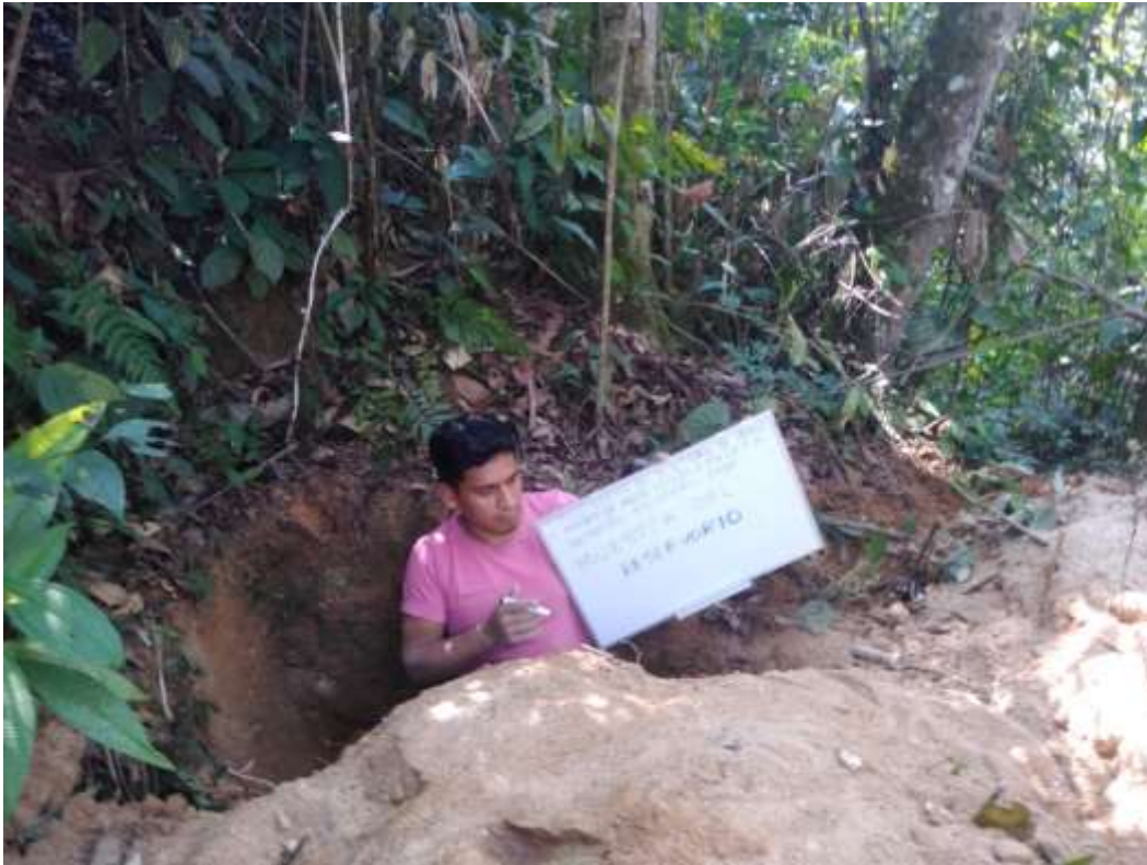
FOTO N° 7: calicata del reservorio
