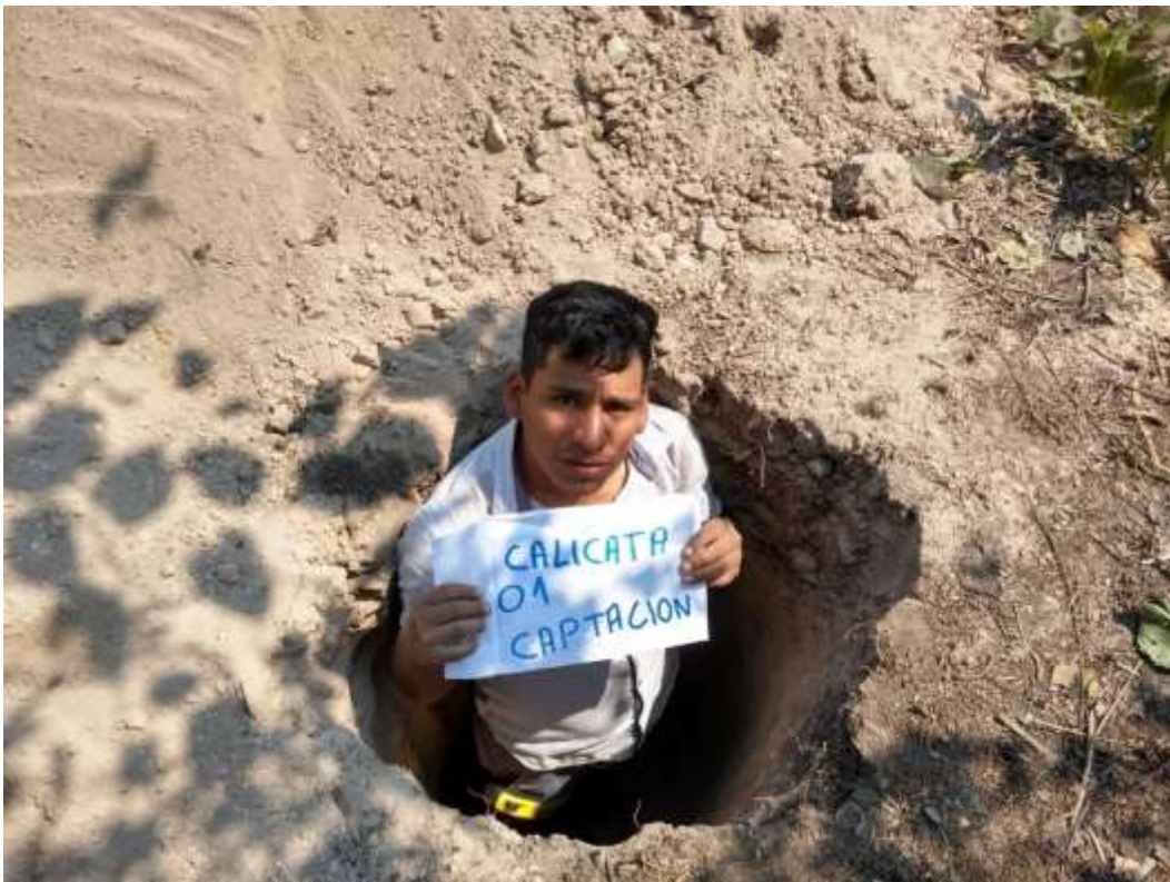
FOTO N° 6: calicata en la captación
