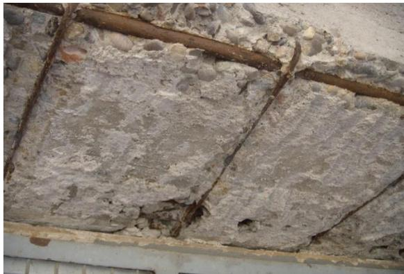
Figura 08: Oxidación en el acero.
