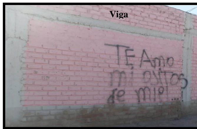
Figura 03. Viga en albañilería confinada. Fuente: Elaboración propia (2016)
