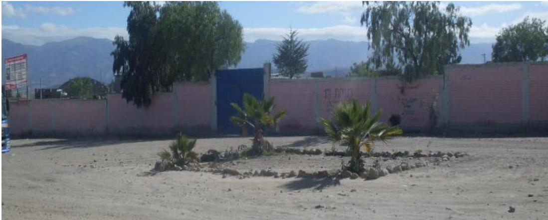
Fotografía 01: Cerco perimétrico de la institución educativa José Abelardo Quiñones 38984-3 mx/p, distrito San Juan Bautista, provincia Huamanga, región Ayacucho
