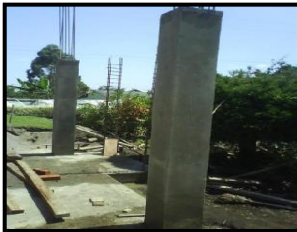
Figura 02. Columna de concreto
