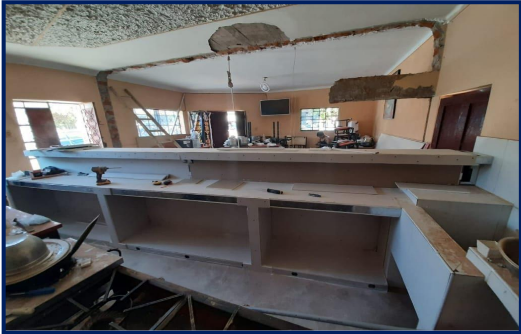
Imagen 01: A sugerencia del presente trabajo de investigación se iniciaron los trabajos de remodelación en el área de cocina.
