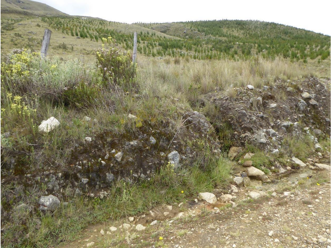
Figura 12. Fotografía de vista panorámica de tipo de terreno rocoso en la captación de ladera.
