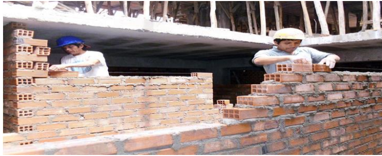
Figura 1. Albañilería o Mampostería
