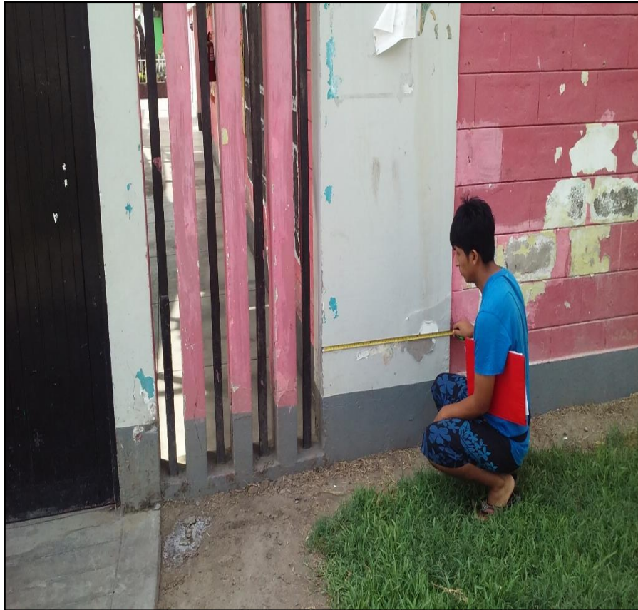
Medición de columna de la fachada en la UM 01 de la I.E 304.
