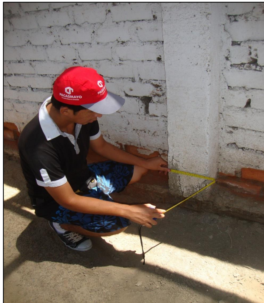
Medición de columna en la UM 06 de la I.E 304.
