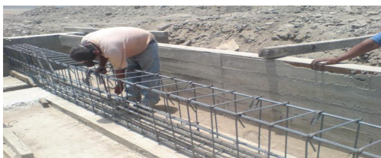
Figura 31. Amarre de Viga de Concreto Armado
