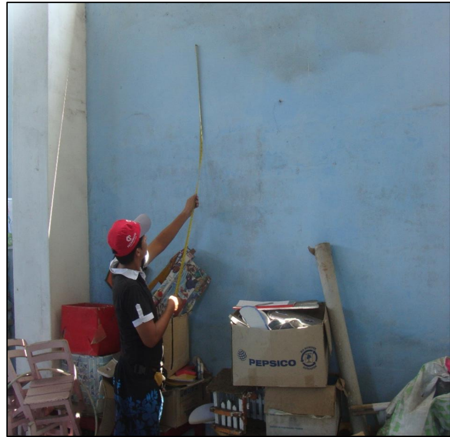
Medición de la altura del muro en la UM 04 de la I.E 304.
