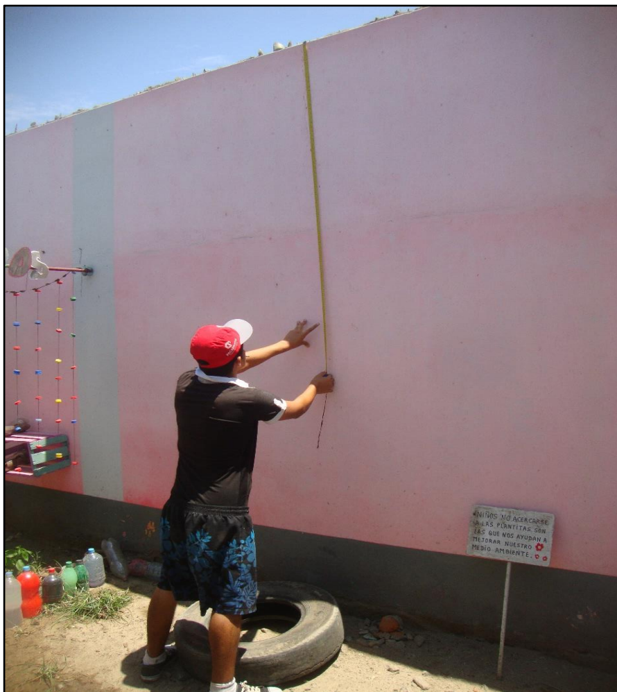
Medición total del muro con toda y viga en la UM 08 de la I.E 304.
