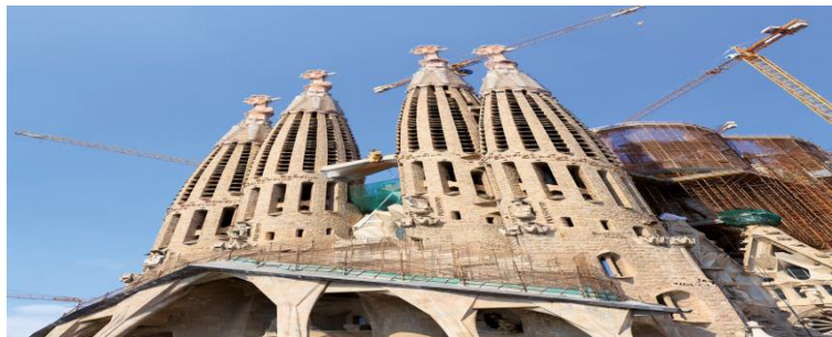
Figura 29. Estructuras de concreto armado
