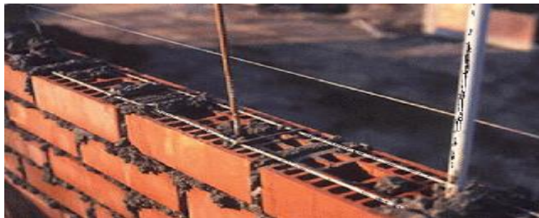
Figura 4. Albañilería Armada Nota. Fuente: (Arquitectura 21) 11
