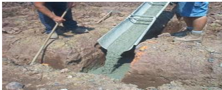
Figura 25. Vaciado de cemento corrido Nota. Fuente: (Garzón) 39
