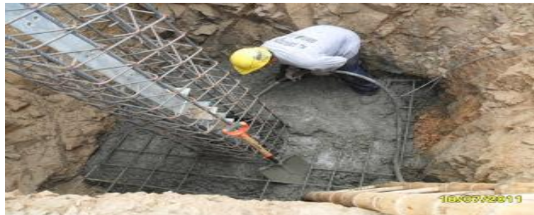
Figura 15. Llenado de Zapata Nota. Fuente: (Basa Perú) 29
