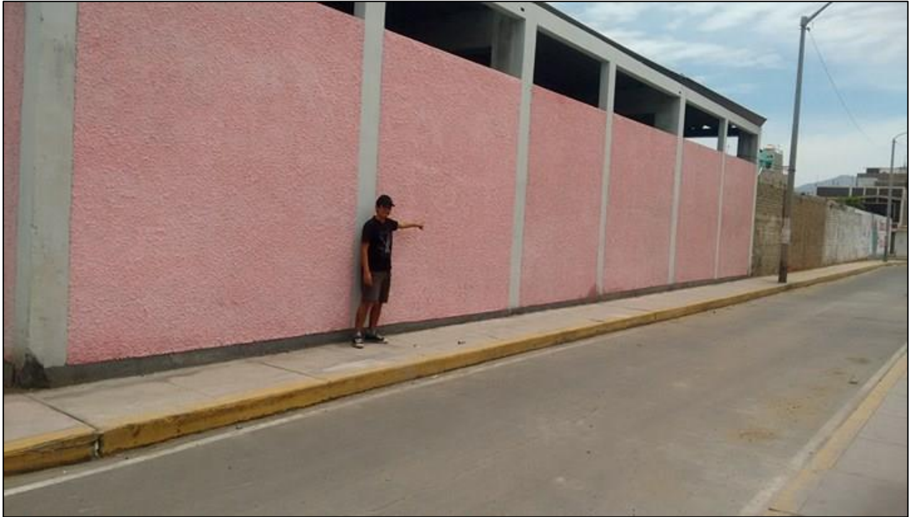
Vista lateral derecha de la Institución Educativa N° 304, del distrito de Chimbote Provincia del Santa, Región de Ancash.
