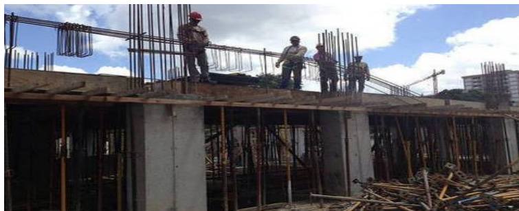
Figura 30. Columnas de concreto armado
