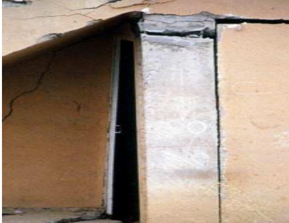
Figura 51. Rotura por tracción en columna Nota. Fuente: (Navarro y Pino) 60
