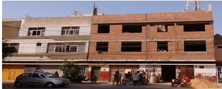
Figura 13. Muro Portante Nota. Fuente: (Adalberto) 26
