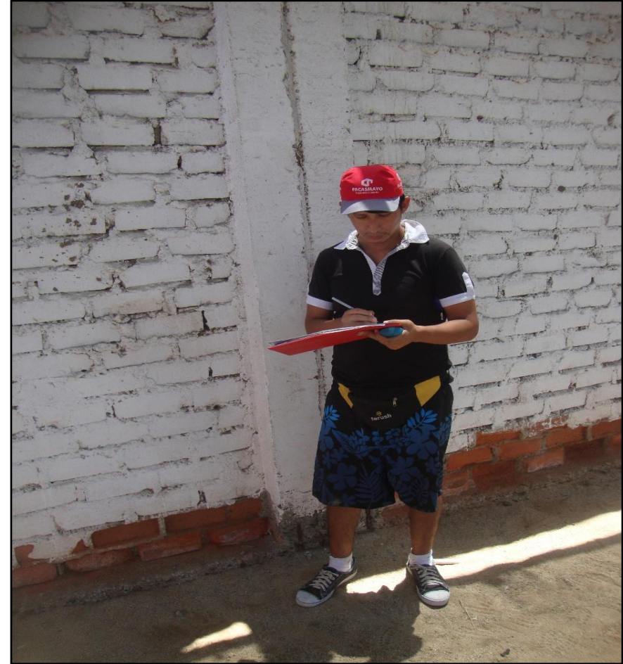
Determinación de la patología erosión en la UM 07 de la I.E 304
