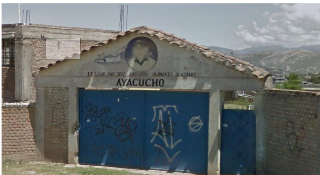
Figura 45. Vista de la puerta n° 2 de la Institución Educativa. Fuente: Elaboración propia.
