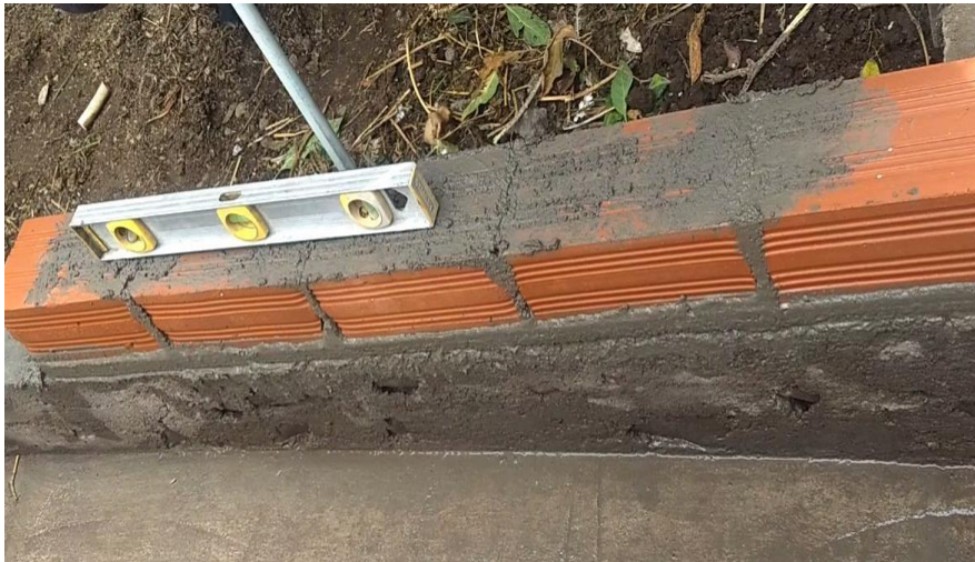
Figura 1. Proceso constructivo de albañilería.
