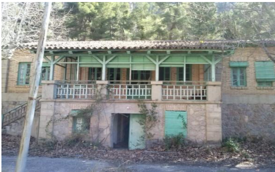
Figura 18. Vivienda totalmente sucia a causa de la polvareda. Fuente: Fichas de patologías de Camarasa (p. 20).
