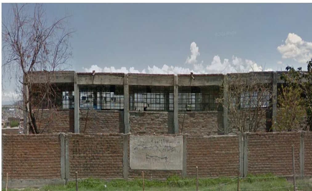
Figura 44. Vista del lado exterior del cerco perimétrico. Fuente: Elaboración propia.
