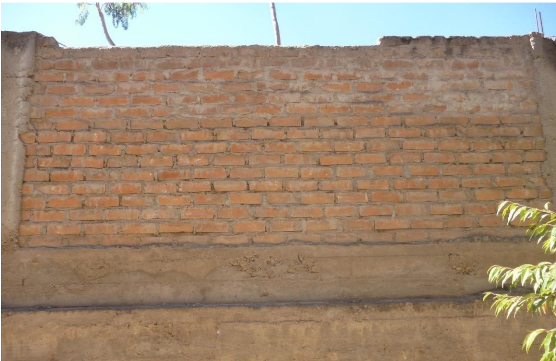
Figura 49. Vista de la cara interna de un muro del cerco perimétrico. Fuente: Elaboración propia.
