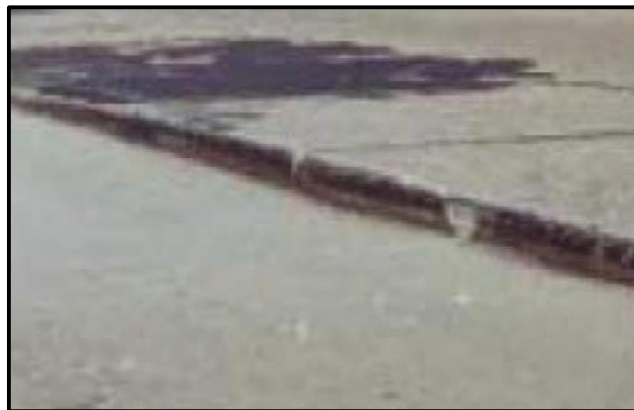
Figura 10. Falla de Escala Fuente: (Vásquez Varela, 2002)
