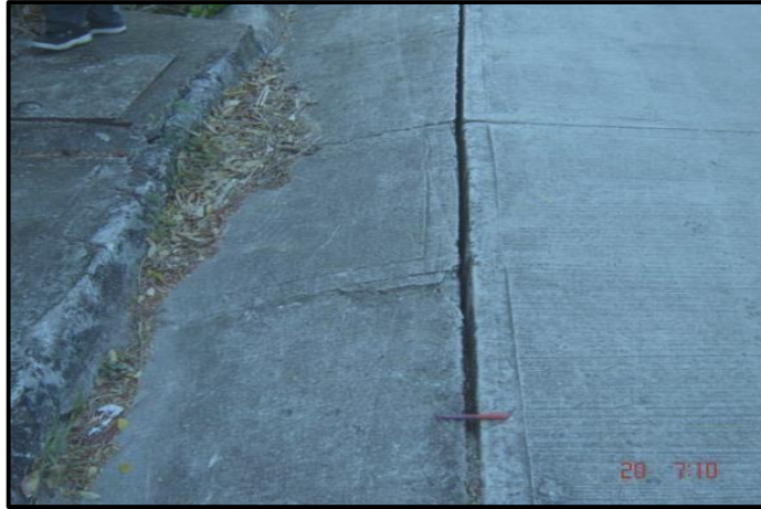
Figura 12. Desnivel carril berma Fuente: (Vásquez Varela, 2002)
