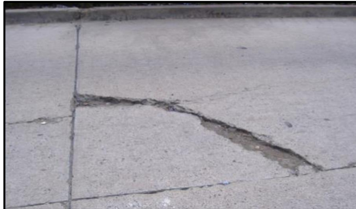
Figura 23. Descascaramiento de esquina Fuente: (Vásquez Varela, 2002)
