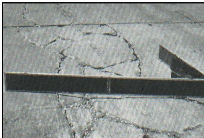
Figura 19. Falla por Punzonamiento Fuente: (Vásquez Varela, 2002)
