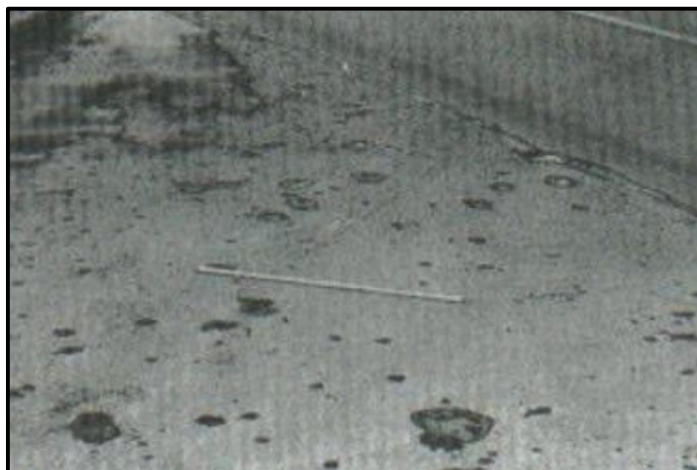
Figura 17. Falla por Popouts Fuente: (Vásquez Varela, 2002)
