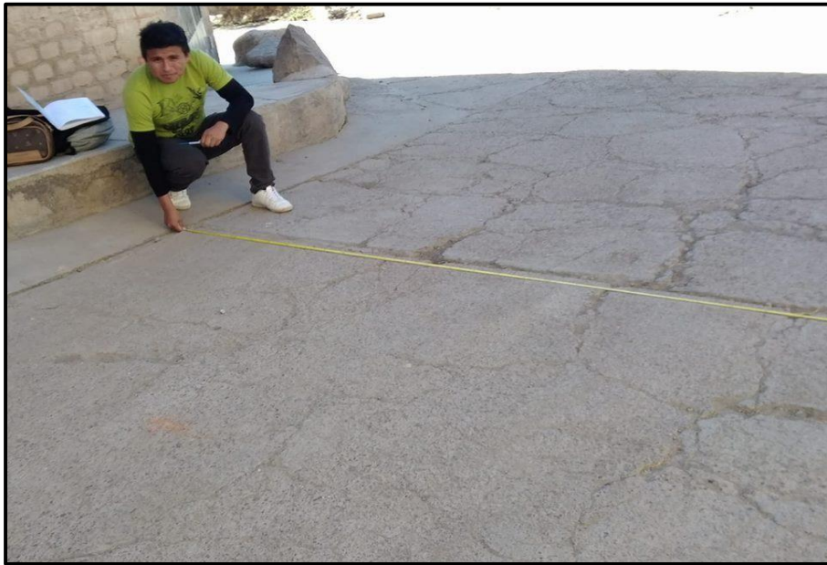
Figura 28. Medición de la losa del Jirón Mariscal Cáceres – Santa Ana
