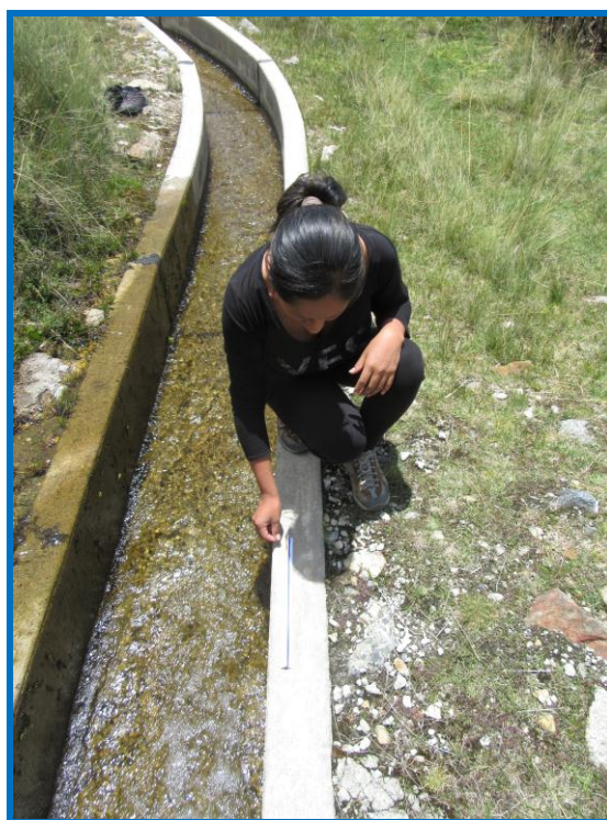
Imagen 3: Realizando la medición de la patología que afecta al concreto.
