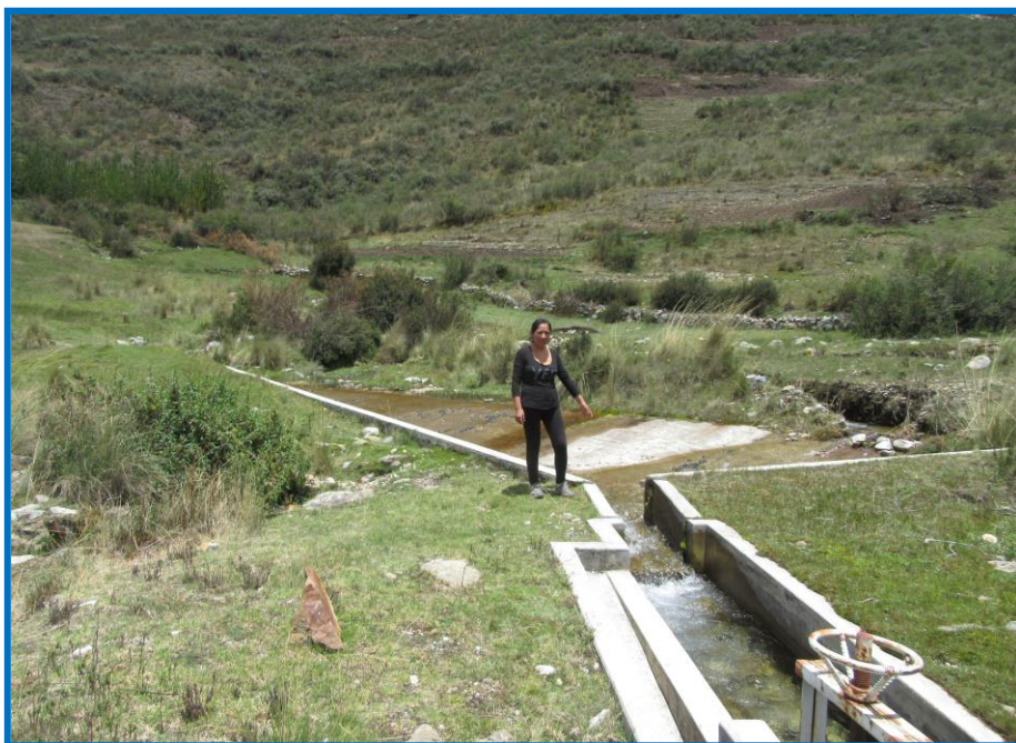
Imagen 2: Vista de la toma del canal de Pocyac
