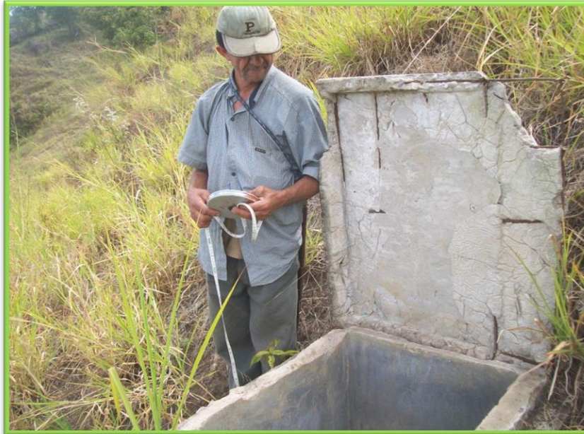
Foto N° 7. vista de una de las crp actuales
