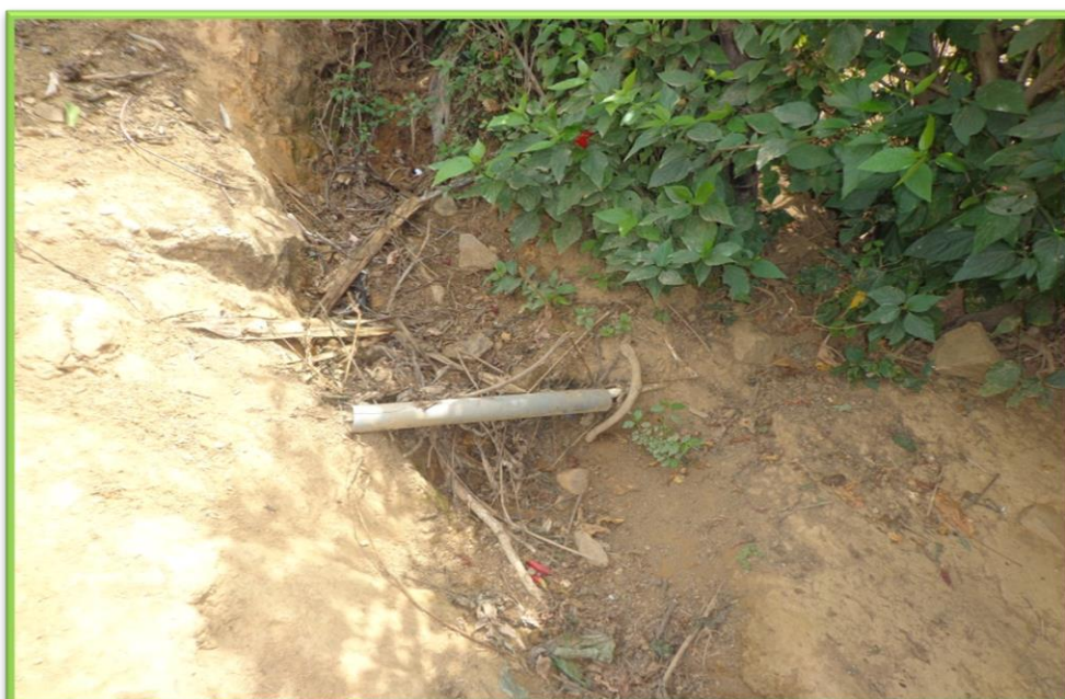
Foto N° 12. línea de conducción a cambiar para el proyecto.
