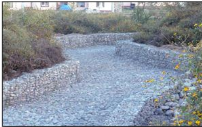
Figura 16. Revestimiento de canal con gaviones.
