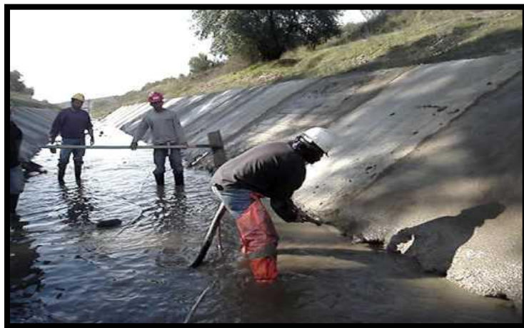
Figura 15. Revestimiento de canal con mortero.
