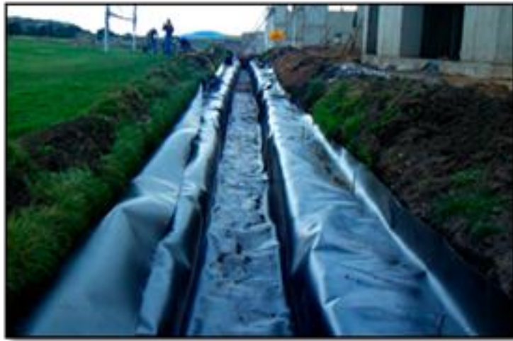
Figura 17. Revestimiento de canal con geo membranas.
