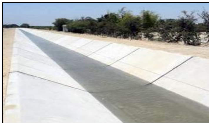
Figura 14. Revestimiento de canal con concreto Carlos leigh
