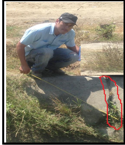
Figura 27: Junta dañada.
