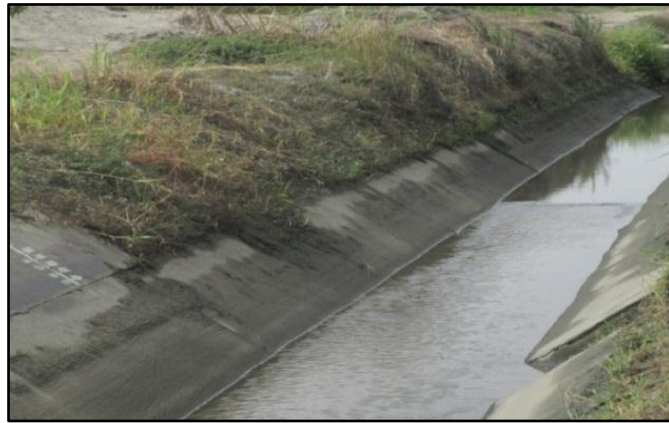
Figura 05. Vegetación en canal en canal Carlos Leigh.
