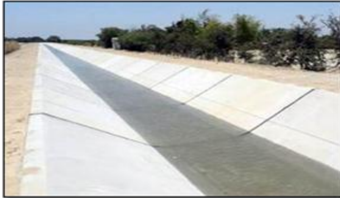
Figura 07. Canal de conducción abierta Carlos Leigh.
