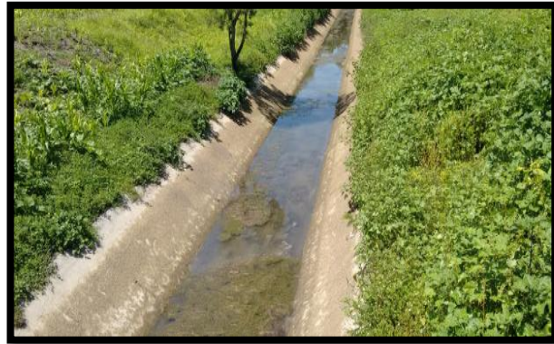
Figura 08. Sedimentación en fondo de canal.
