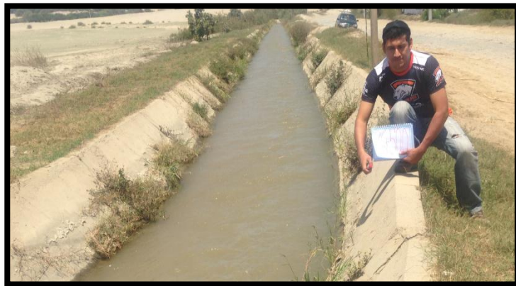
Figura 9. Canal de riego Carlos Leigh - Ancash.
