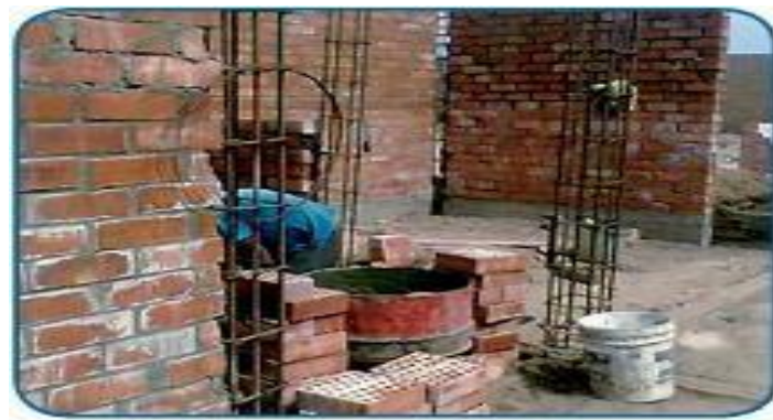
Imagen N°5: Albañilería confinada. (Rojas N.)
