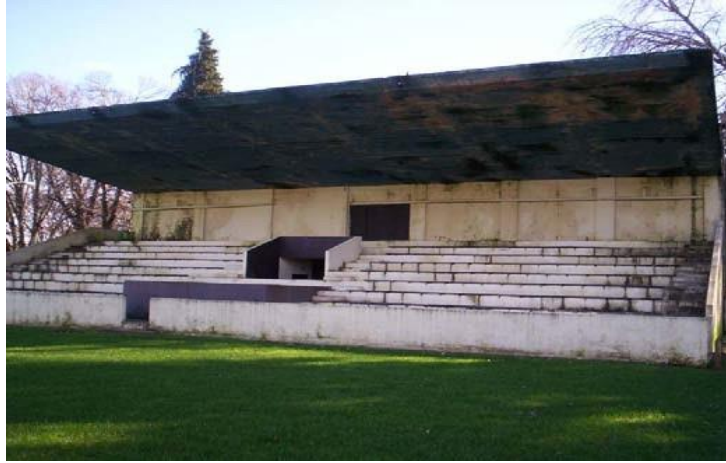
Imagen N°1: Vista Panorámica – Marquesina (Monroy R.)
