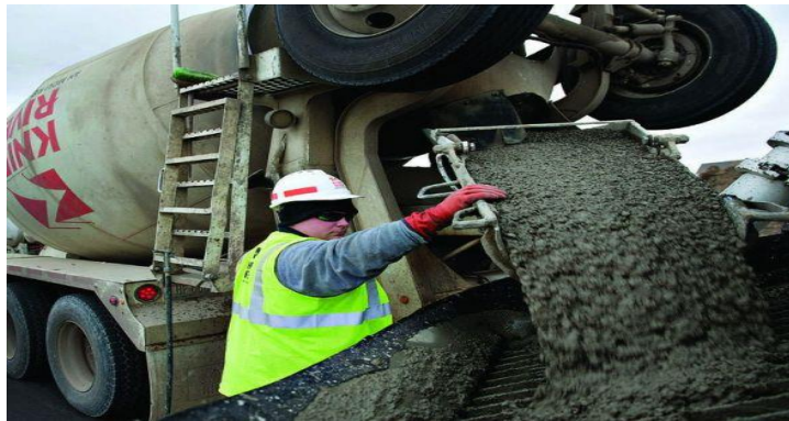
Imagen N° 13: Concreto en albañilería confinada.
