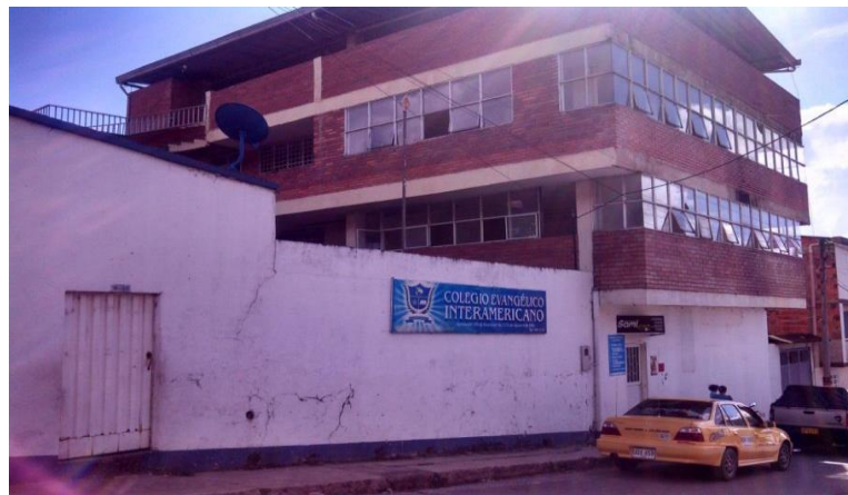
Imagen N°3: Fachada de la edificación. (Velasco E.)
