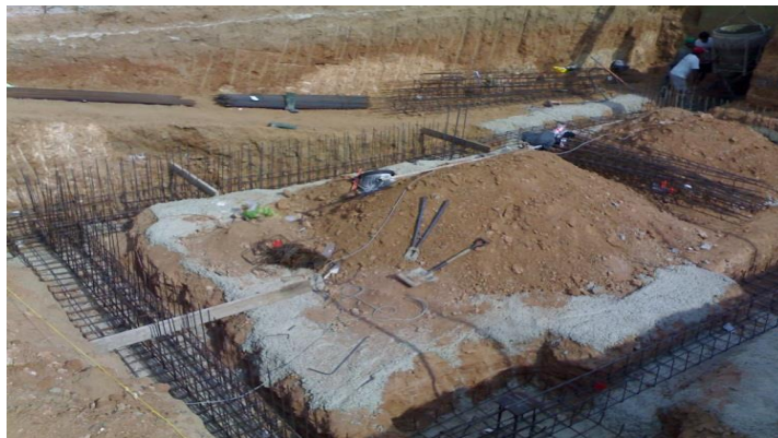
Imagen N° 7: Cimentación. (Rojas R.)
