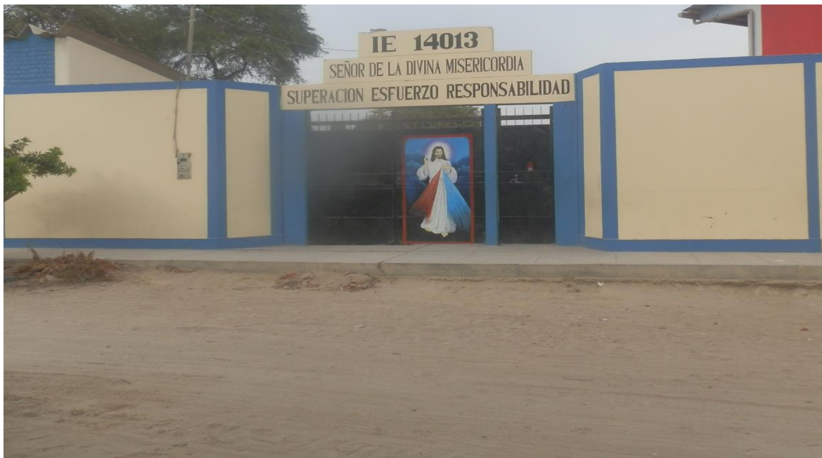
Imagen N° 21: Frontis del cerco perimétrico de la I.E Señor de la Divina Misericordia.
