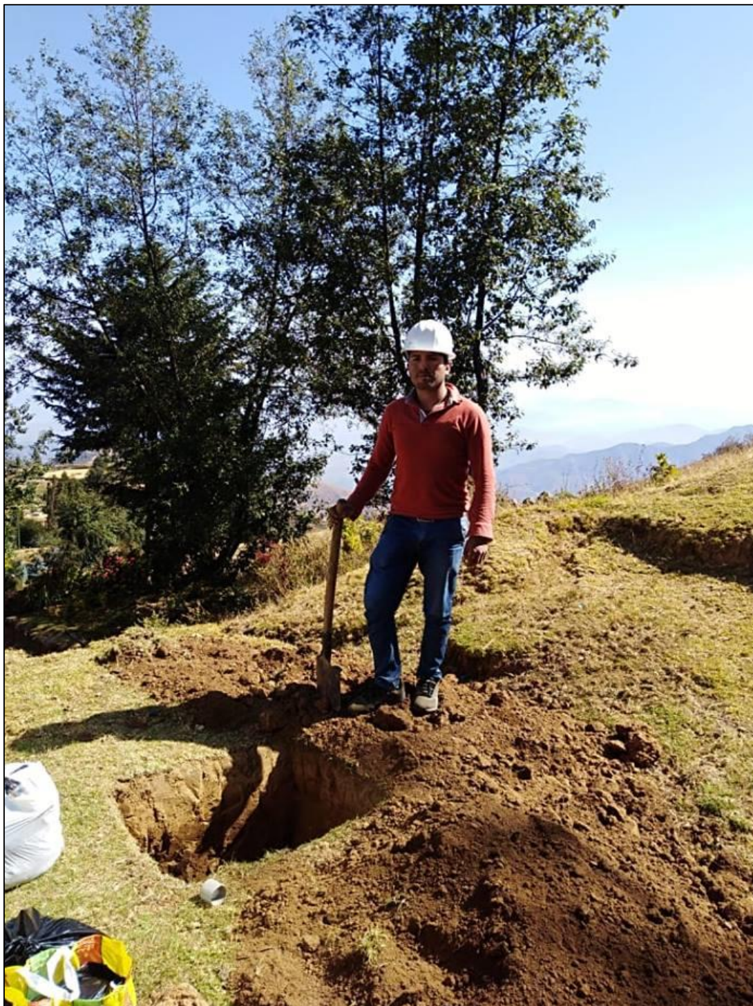
Figura N° 19: Calicata N°2 realizada en el reservorio en reservorio de almacenamiento h= 1.5 m profundidad promedio para la toma de muestra.
