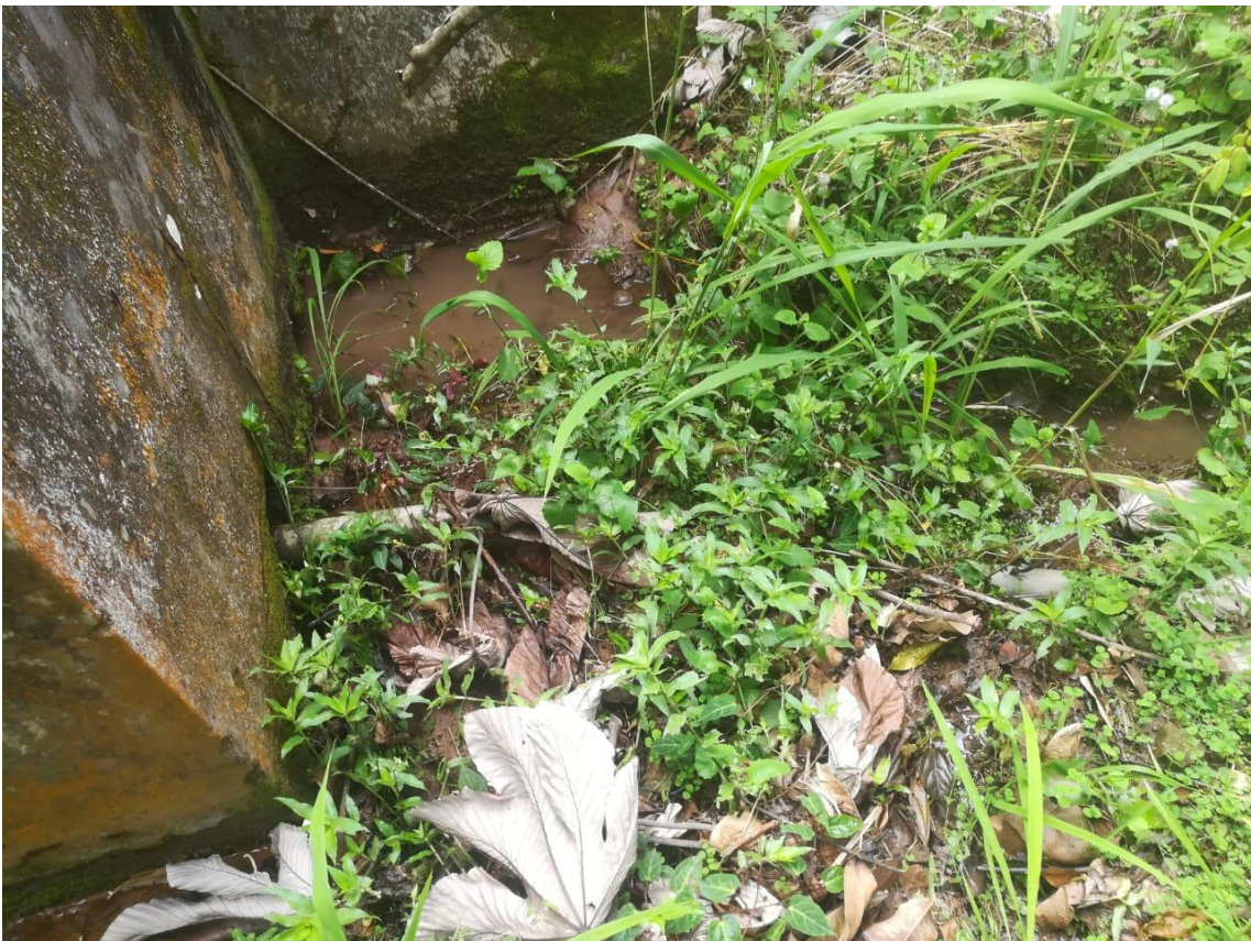
Figura 22: Inicio de la línea de aducción desde la caja de valvulas.
