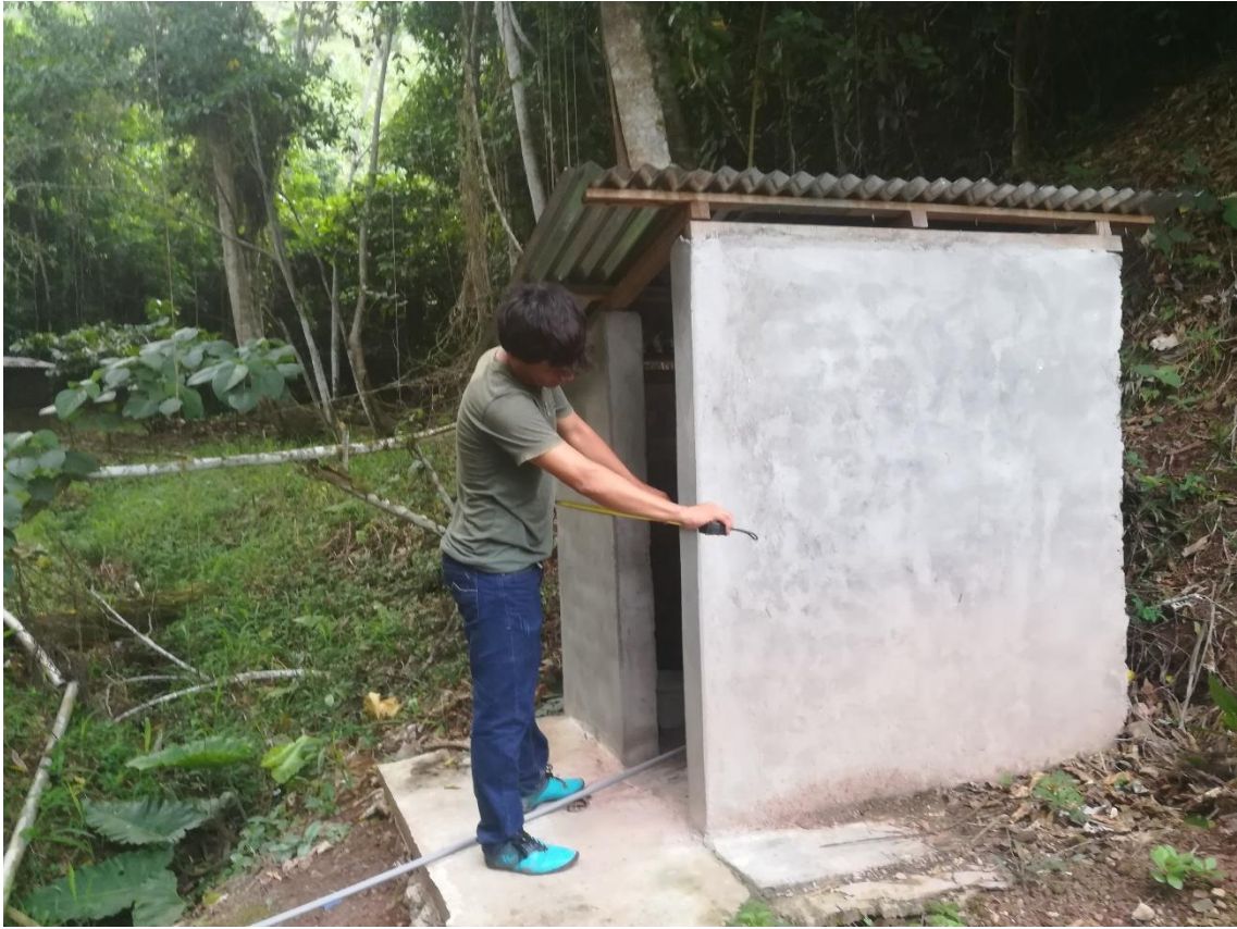
Figura 25: Recoleccion de datos de la caseta de cloracion
