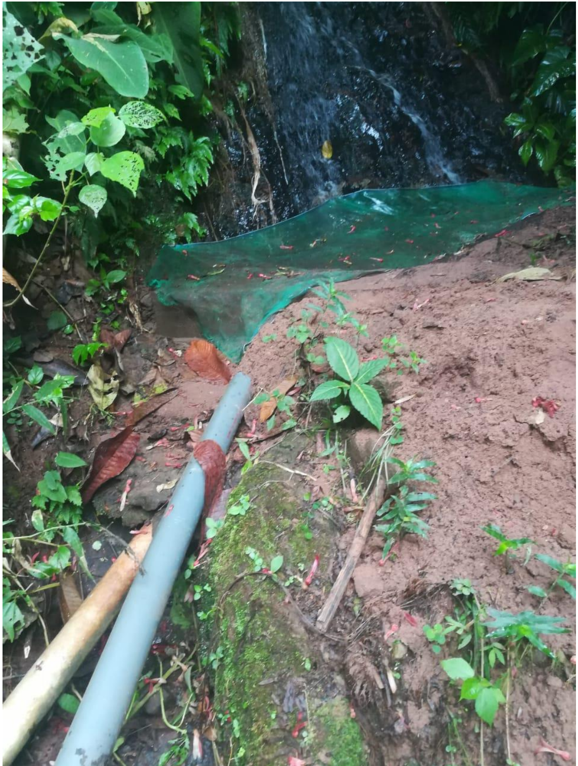
Figura 16: Fotografía de la captacion
