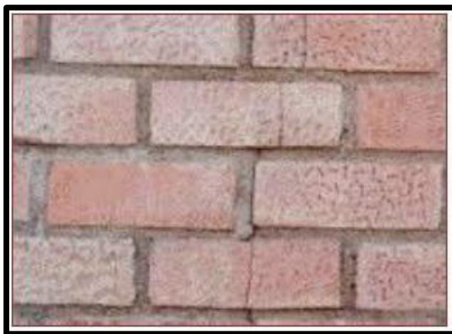
Figura 7: Fisuración
