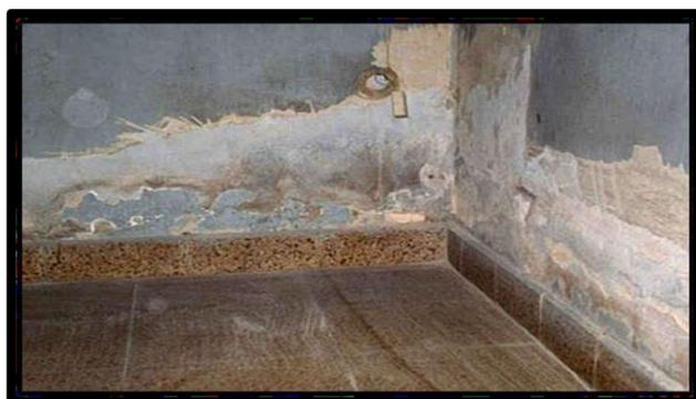
Figura 9: Humedad (filtración)
