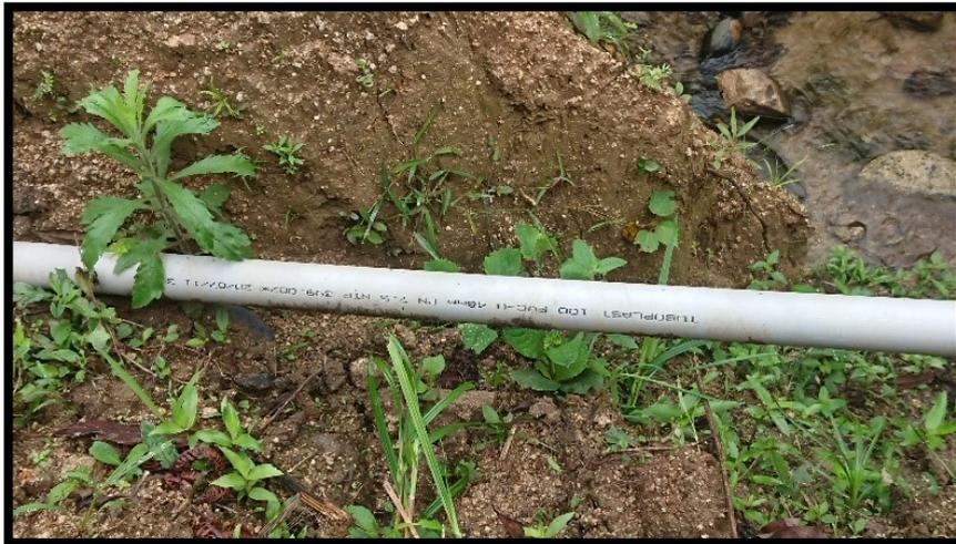
**Figura 18:** Tubería expuesta
