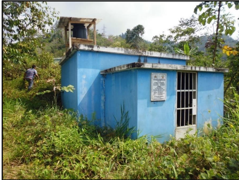
Figura 24: Reservorio de 45m 3
