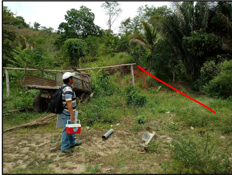
Figura 29: Línea de aducción.
