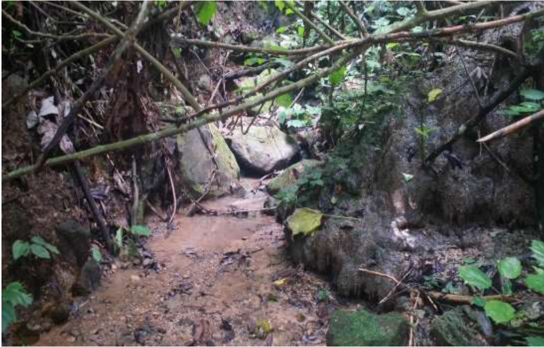
figura 24. Estado situacional de la captación
