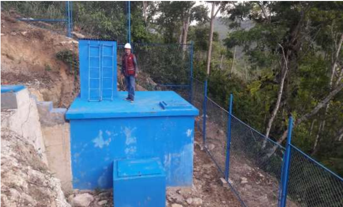
figura 25. Estado situacional del reservorio de la Comunidad Santa Clara.
