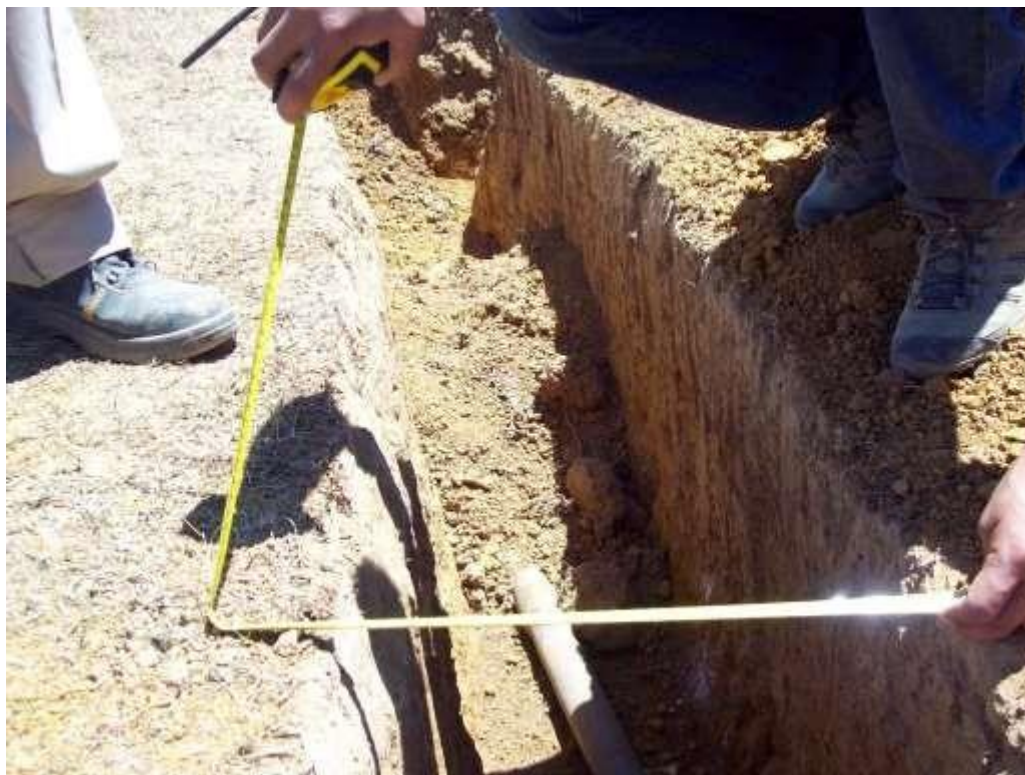
FOTO 1. Excavación de zanjas. Fuente propia
