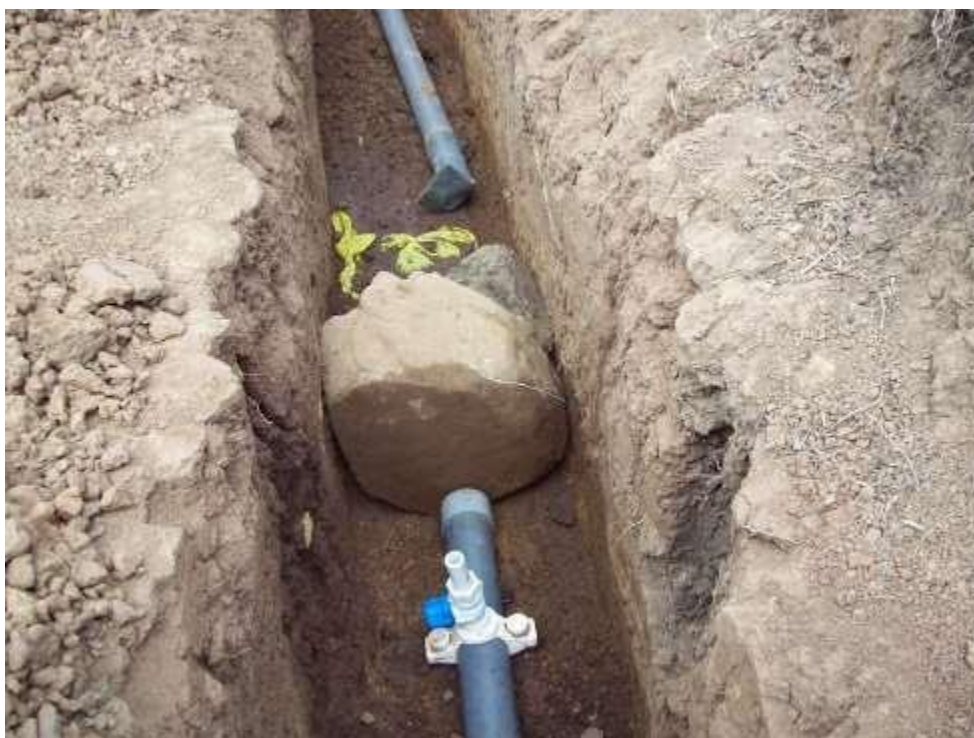
FOTO 3. Instalación de tuberías. Fuente: propia.
