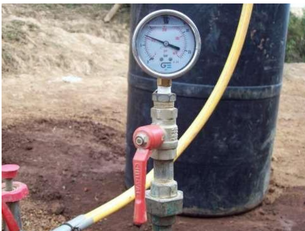
FOTO 4. Medición de presión de agua. Fuente: propia.
