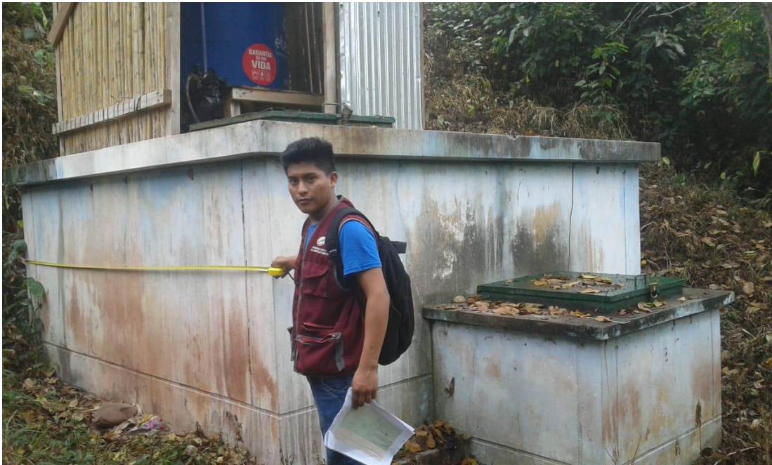
Anexo 10. Evidencia de la evaluación estructural-reservorio.
