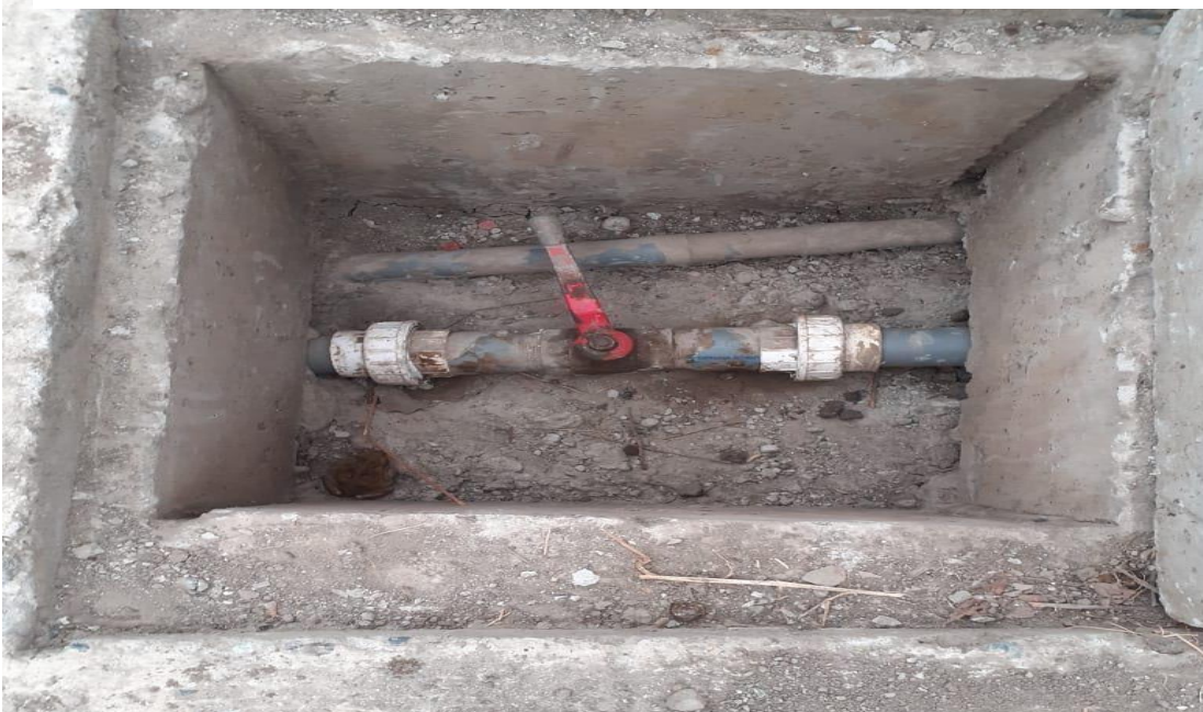
Ilustración 24.Conexiones Domiciliarias
