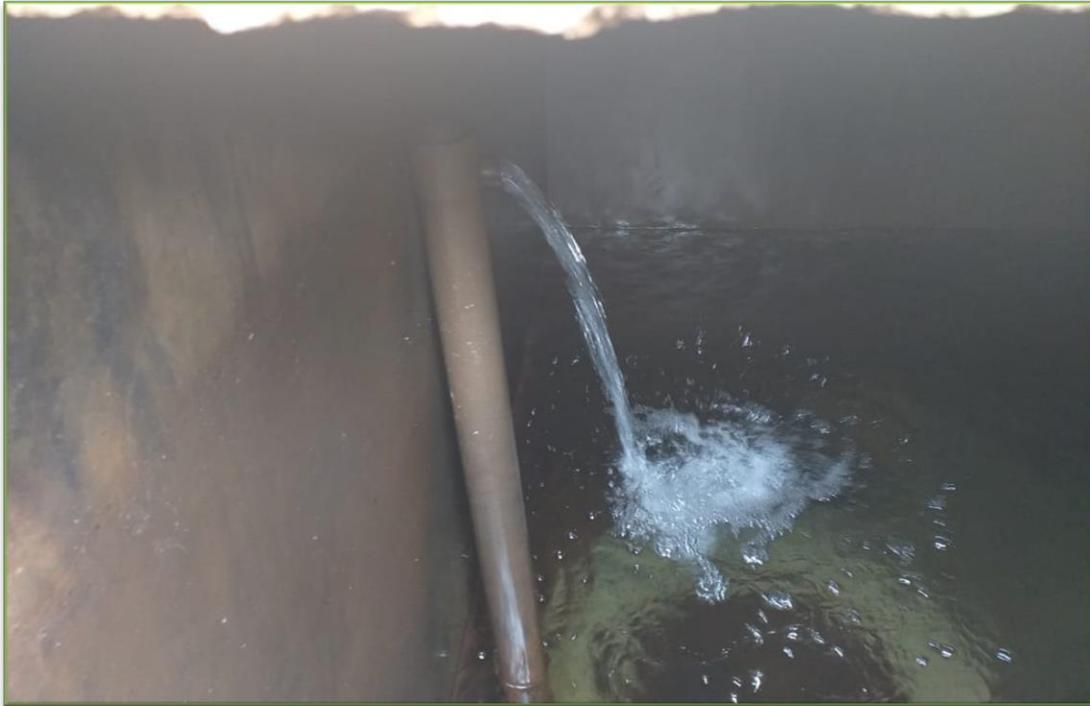
**Fotografía 09:** Se observa el agua ingresando a la cámara rompe presión.
