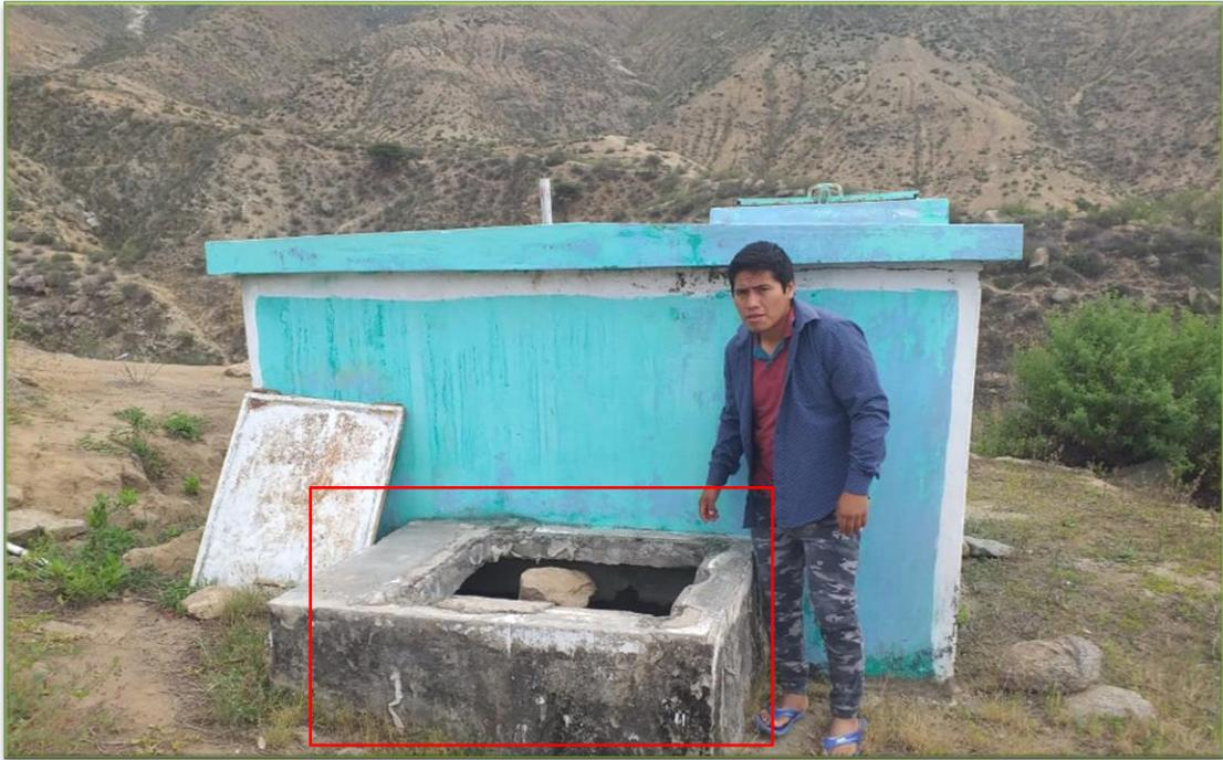
**Fotografía 07:** Se observa la cámara seca del reservorio deteriorado.
