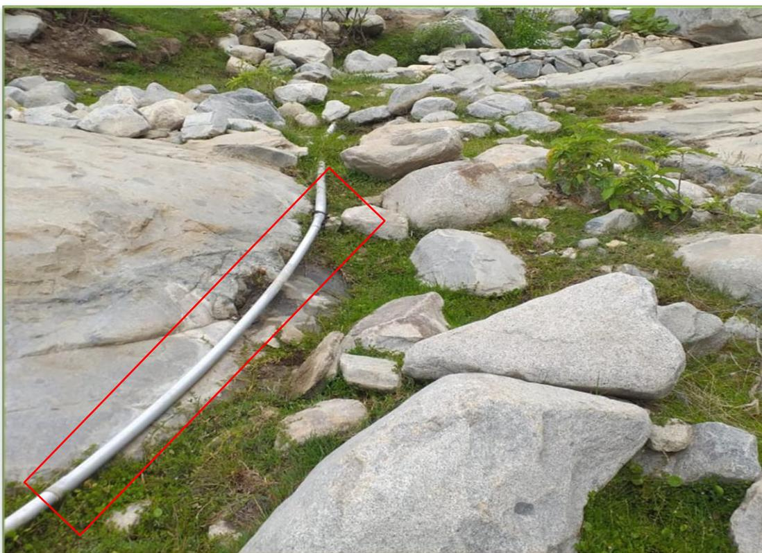
**Fotografía 03:** Línea de conducción salida de la captación existente tubería PVC expuesto a la interperie.
