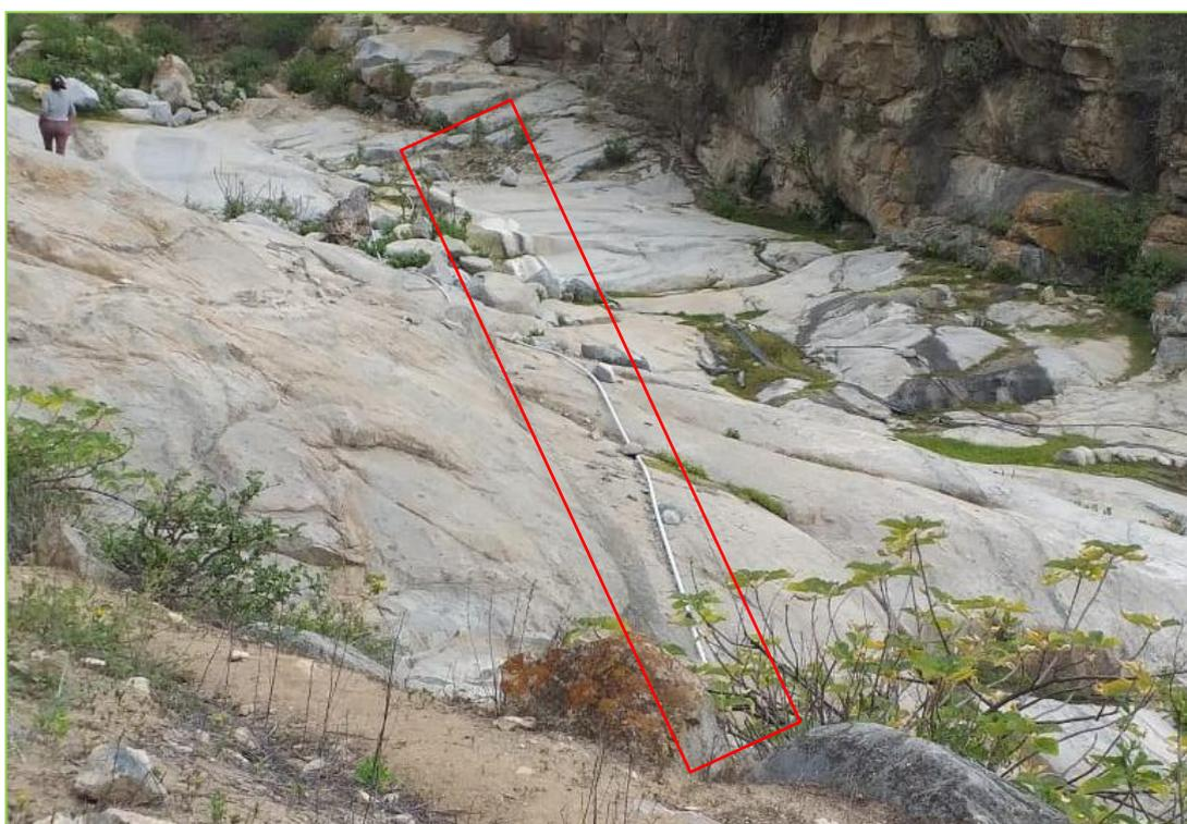
**Fotografía 04:** Se observa tubo pvc de la línea de conducción tendida en zona rocosa
