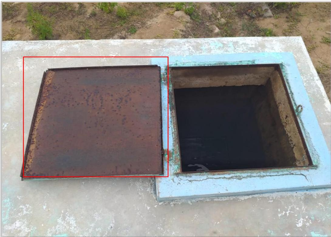
**Fotografía 06:** Se observa la tapa metálica del reservorio con presencia de oxido y corrosión.
