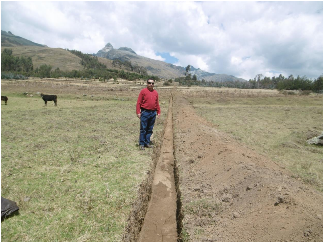
Imagen 1. Tramo de excavación de la línea de conducción
