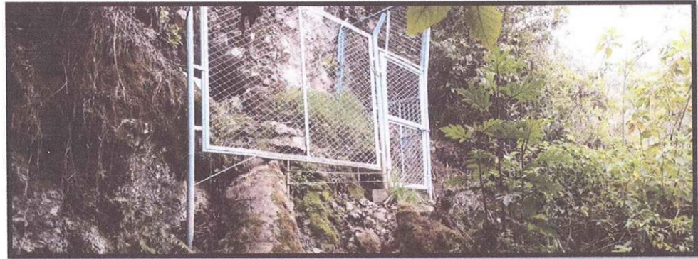
Foto N° 01: En la toma se aprecia la vista panorámica del lugar donde se sacó la primera muestra C – 1.
