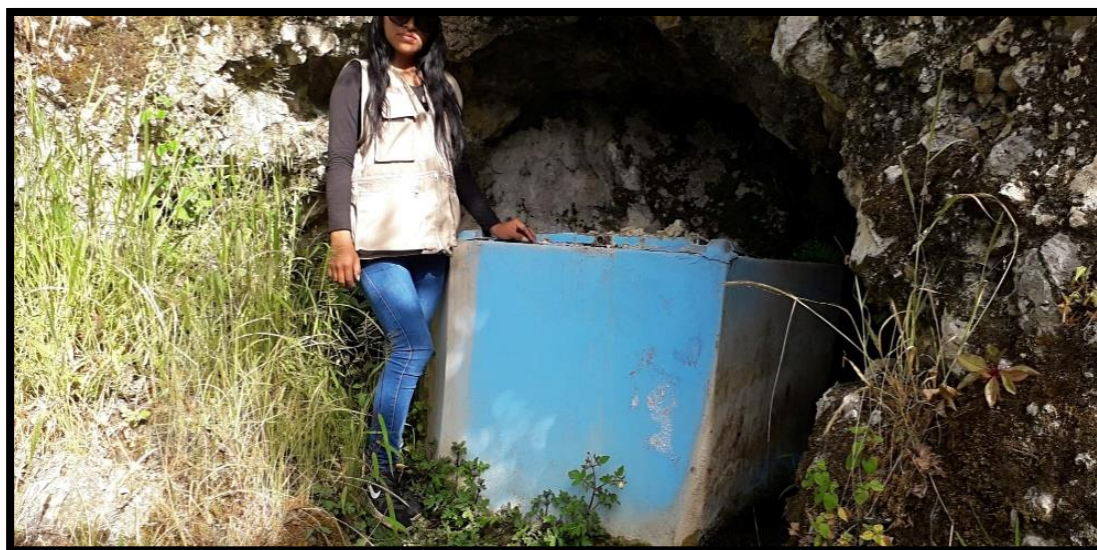
IMAGEN 04: Cámara de captación del caserío de Aricapampa, distrito de Cochorco, provincia Sánchez Carrión, departamento La Libertad.
