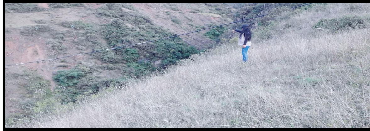
IMAGEN 05: Línea de conducción adosada del caserío de Aricapampa, distrito de Cochorco, provincia Sánchez Carrión, departamento La Libertad.
