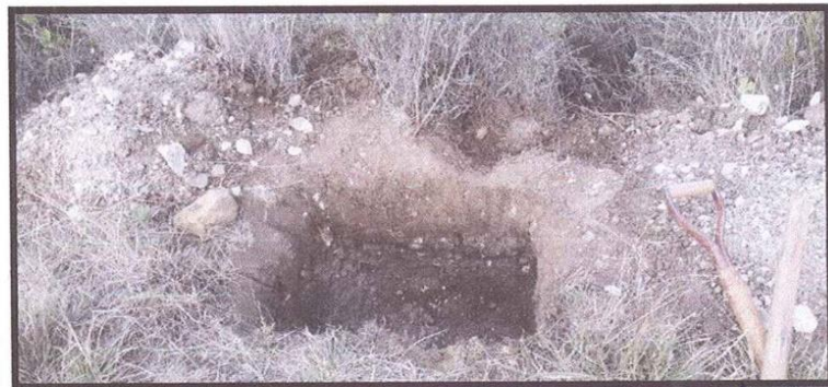
Foto N° 06: En la toma se aprecia una vista detallada de la calicata C-3, donde se encuentra con material orgánico superficial.
