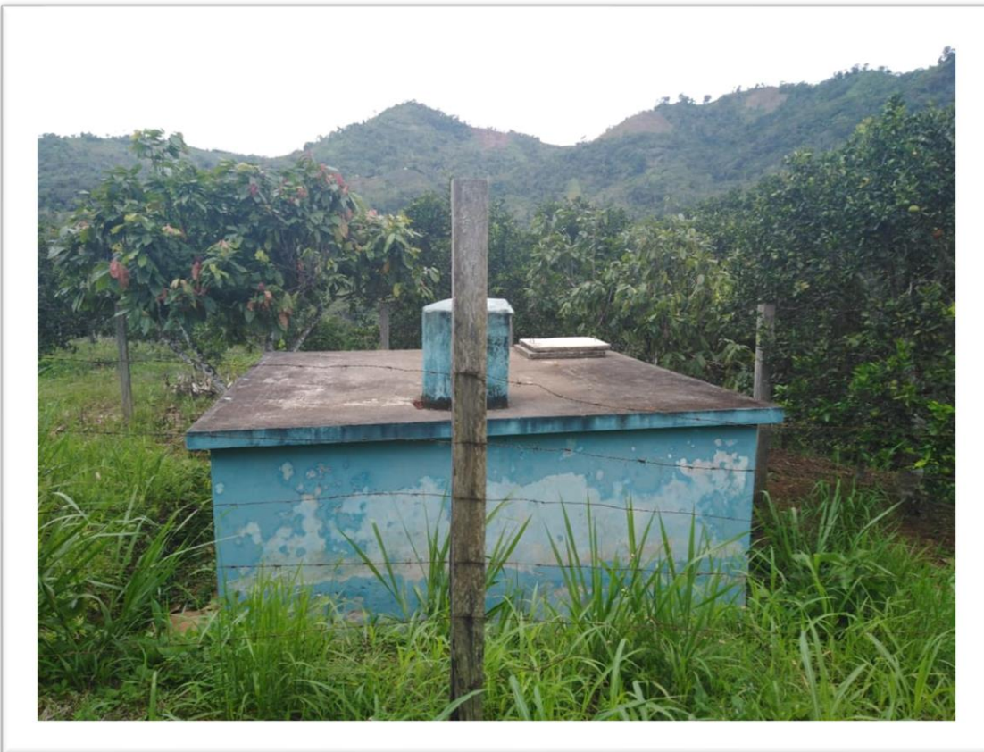
Figura N°18: Estado actual del reservorio
