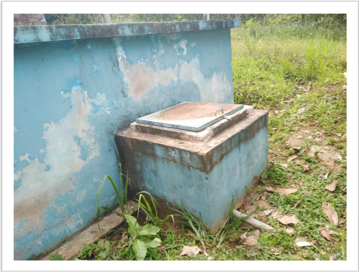
Figura N°19: Estado actual de la caja de válvulas.
