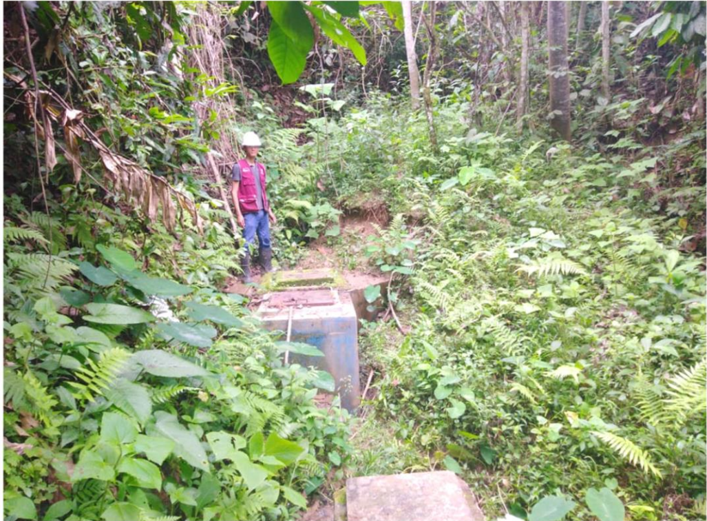
Figura N°13: Estado actual de la captación de agua.
