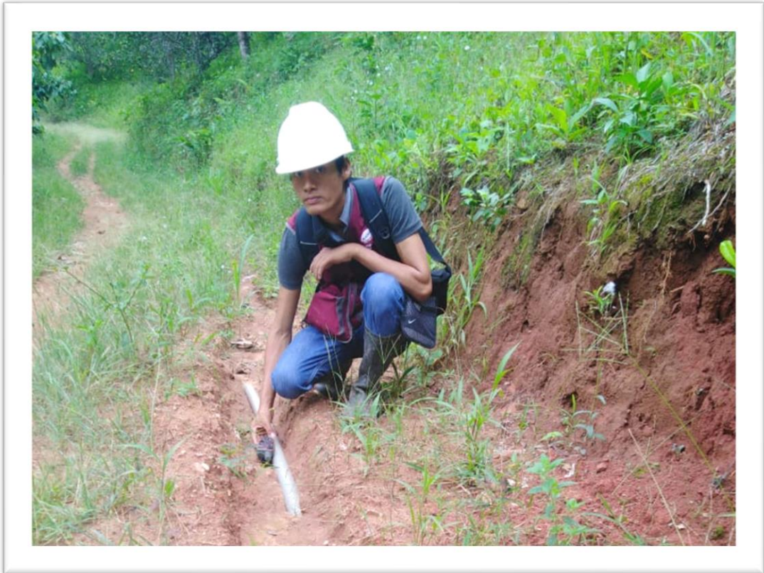
Figura N°15: Estado actual de la línea de conducción.
