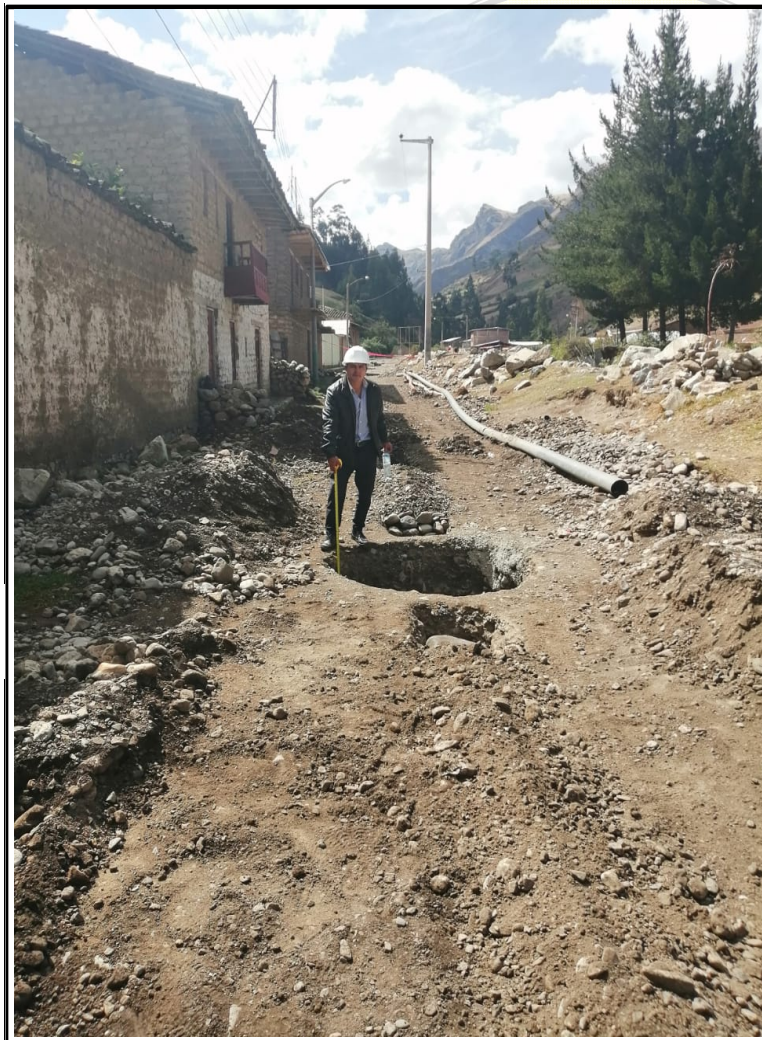
FOTO 01: SE OBSERVA LA EXCAVACIÓN CALICATA C-01.
