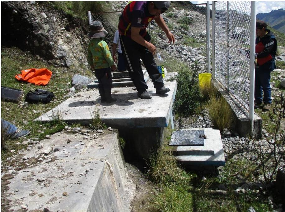
Fotografía N° 04: Se observa la Captación y reservorio juntas (estructura existente), la cual será reemplazada por una nueva.
