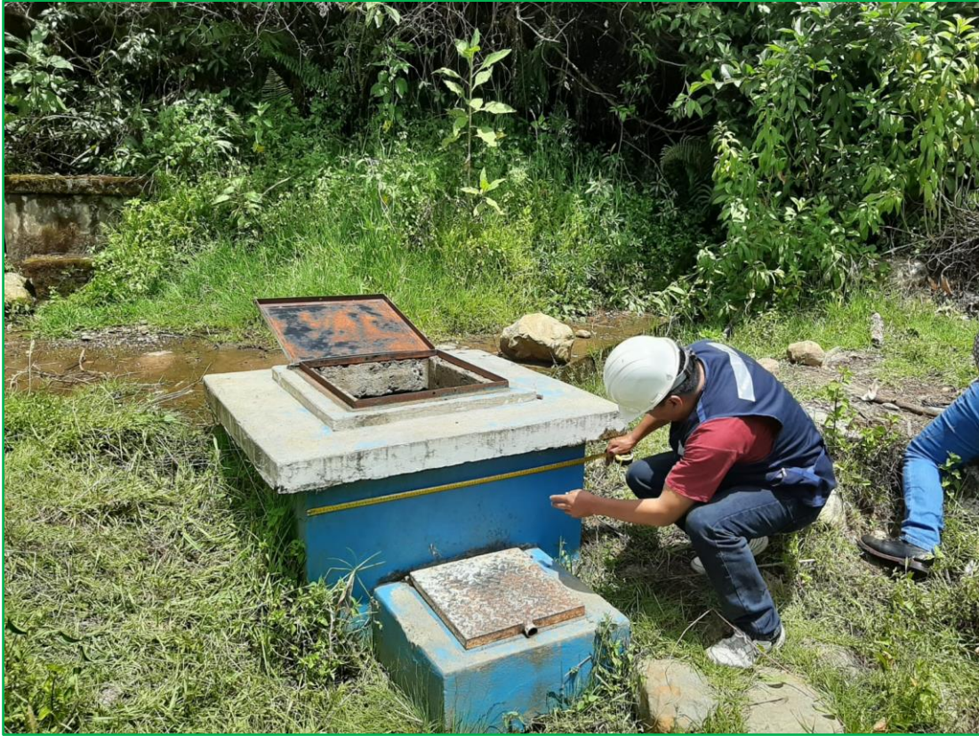
Fotografía N° 03: Realizando las medidas en la cámara de captación existente.
