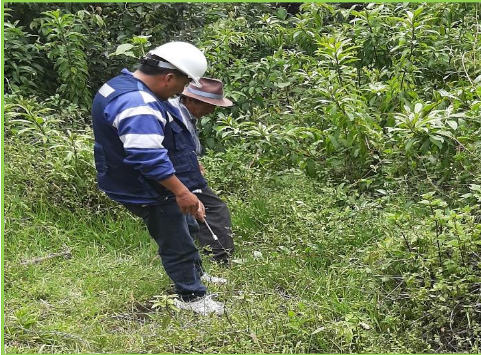
Fotografía N° 05: En el tramo de Línea de conducción
