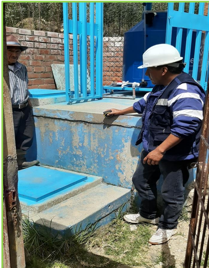
Fotografía N° 08: Realizando la inspección en el reservorio existente.
