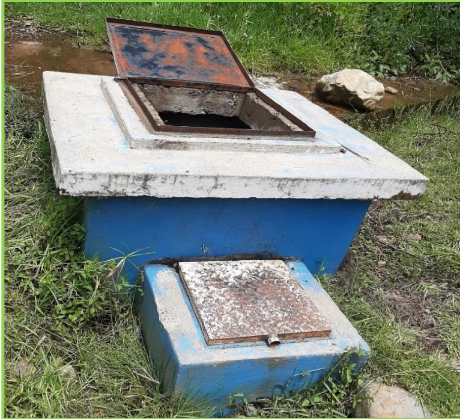
Fotografía N° 01: Captación del caserío de San Antonio
