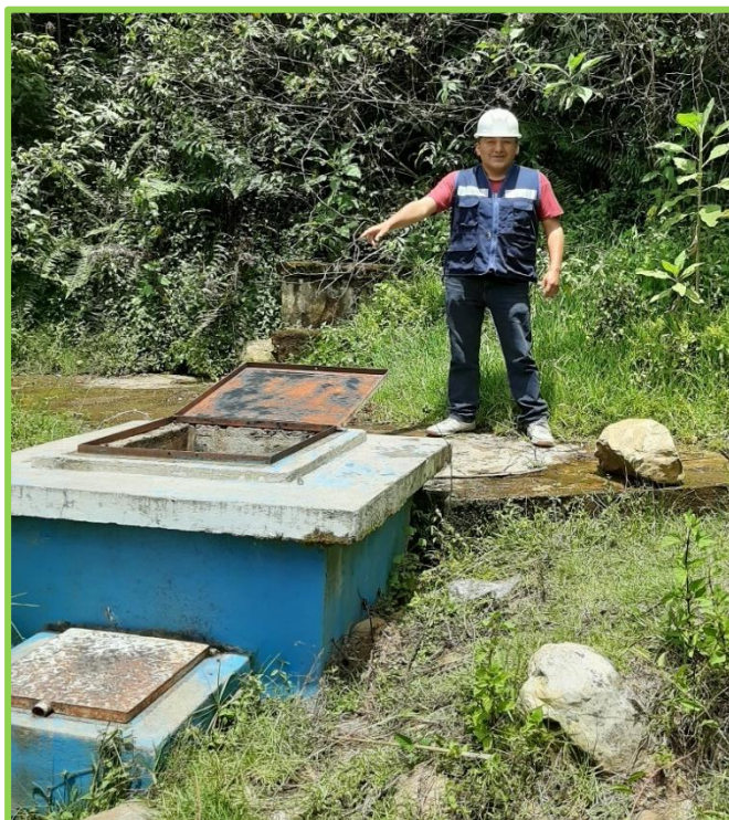
Fotografía N° 02: Realizando la inspección en la cámara de captación.
