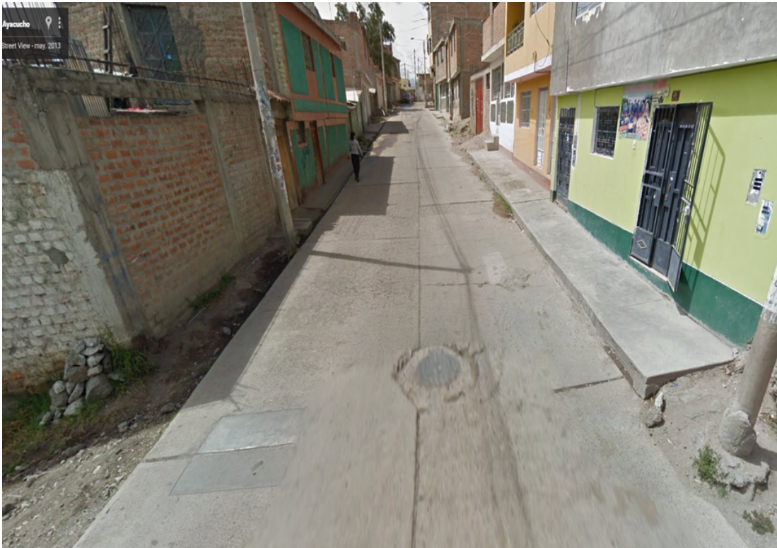
Fotografía 12: Cuadra 4 jr. 24 de Junio, buzón deteriorado.
