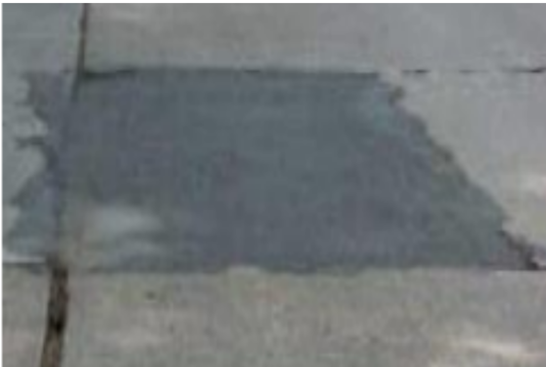
Figura 2.7: Parches deteriorados.
