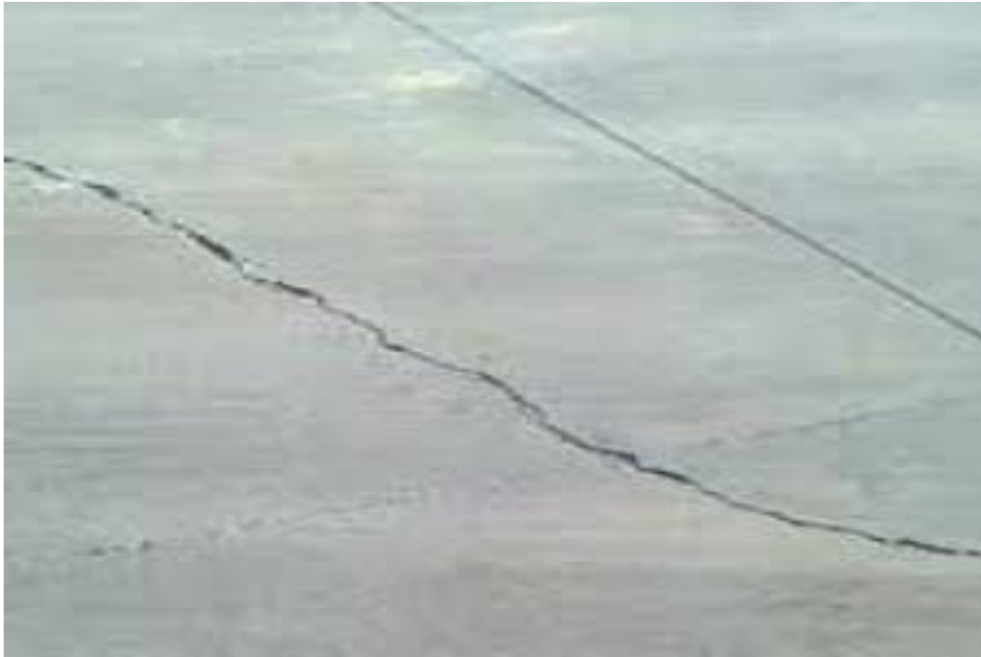
Figura 2.4: Grieta longitudinal.
