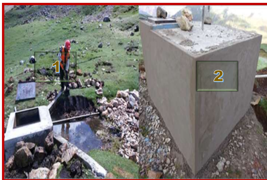
Fotografía N° 01 y 02: captación y reservorio
