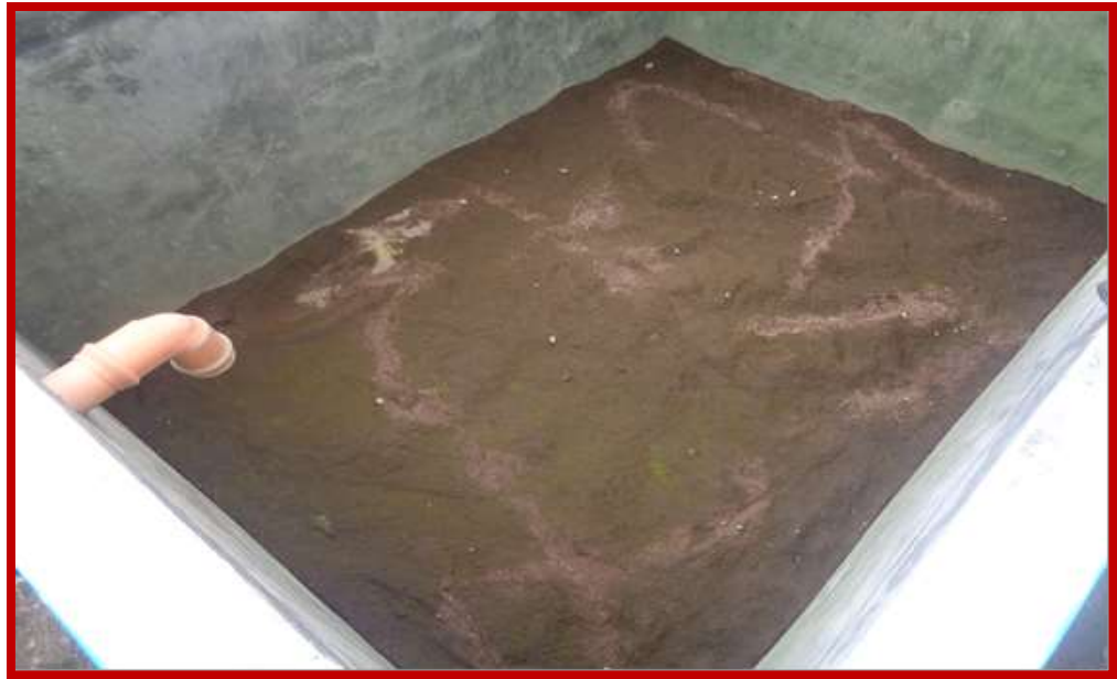
Fotografía N° 04: Vista del fondo de la planta de filtro lento de agua potable.
