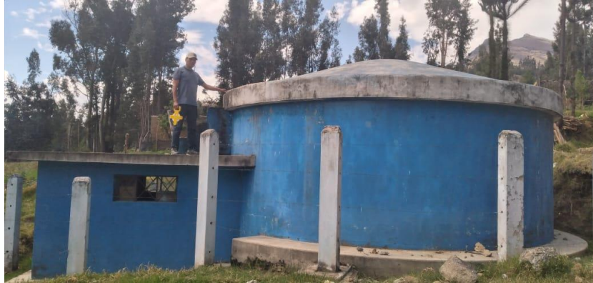
Figura 8. Reservorio circular de 60m 3 Fuente: Elaboración propia
