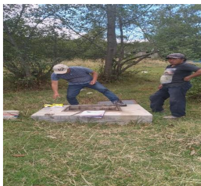
Fotografía 3. Vista de la cámara rompe presión
