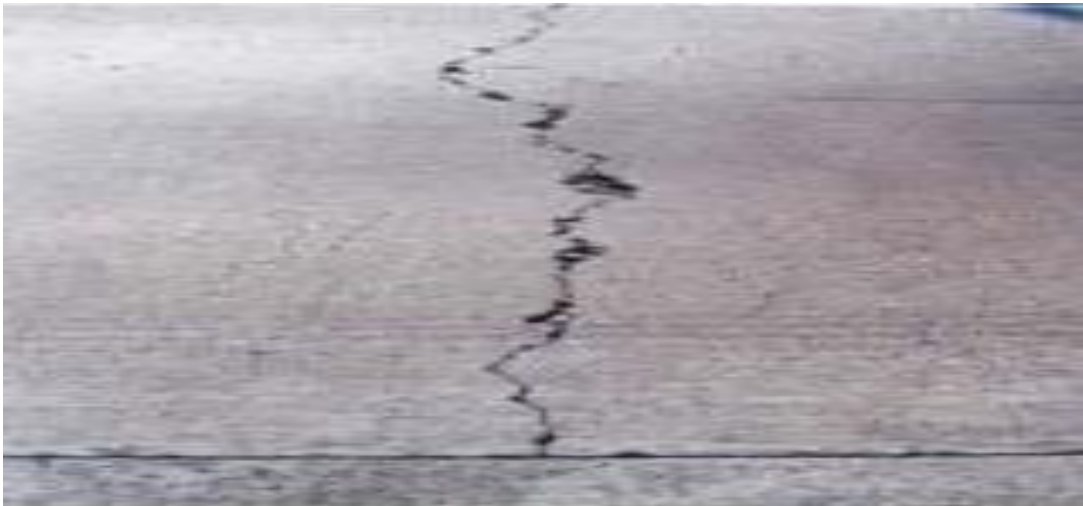
Figura 7 : Grieta transversal.
