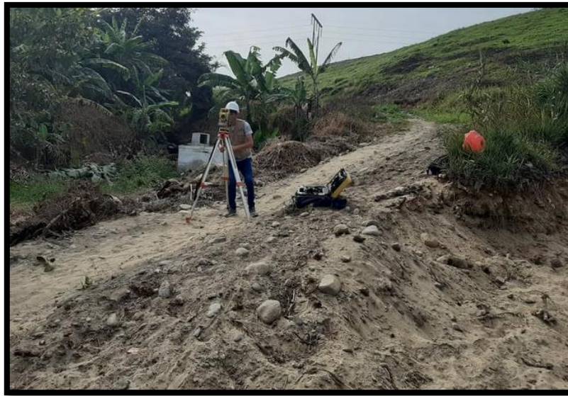
Fotografía 6: Realizando el levantamiento topográfico de la línea de conducción con estación total. Fuente: Elaboración propia (2019).
