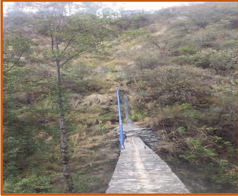
Fotografía 03: Traspase del sistema de agua
