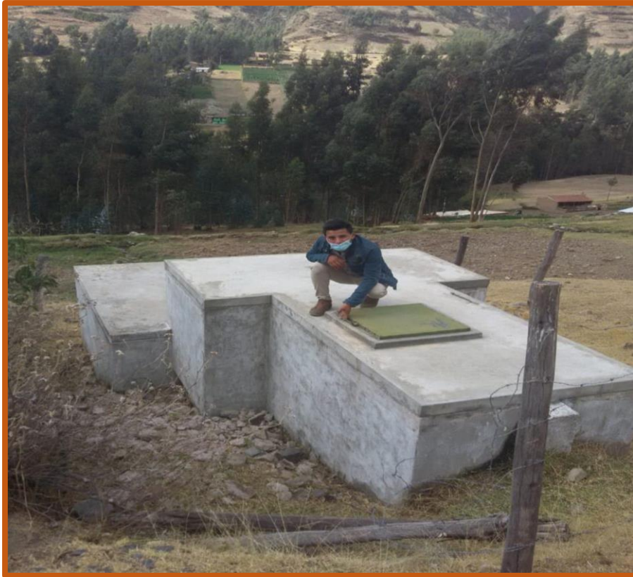
Fotografía 01: captación del sistema de agua
