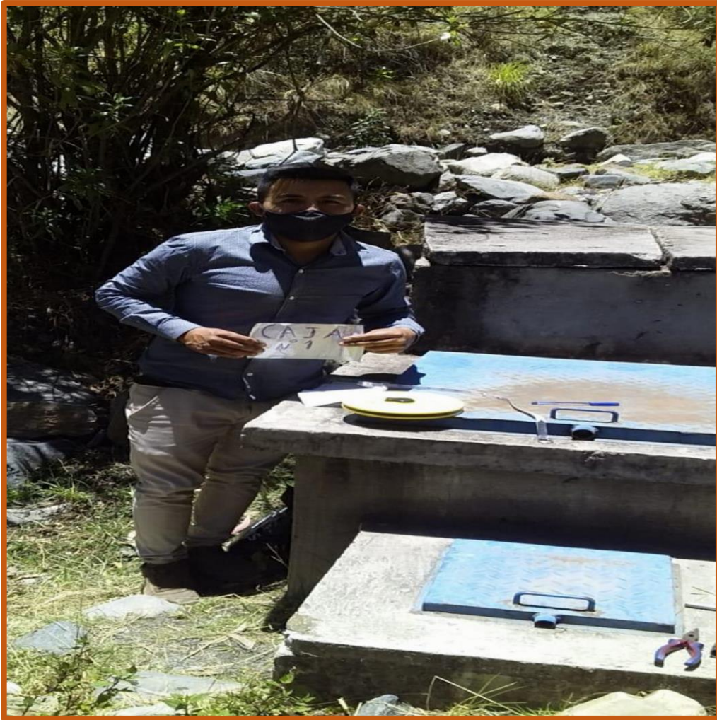
Fotografía 15: Caja de distribución
