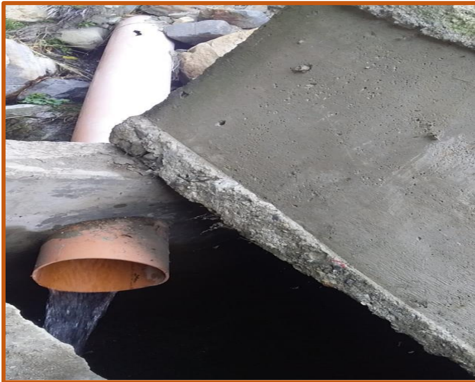
Fotografía 02: Abastecimiento a la captación
