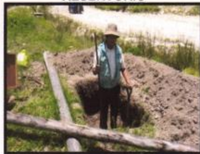
CALICATA 07 ZONA RESERVORIO
