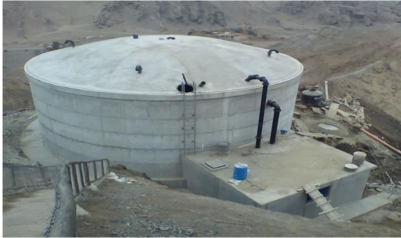
Figura 14: Reservorio apoyado. Fuente: Cesel ingenieros (2016).
