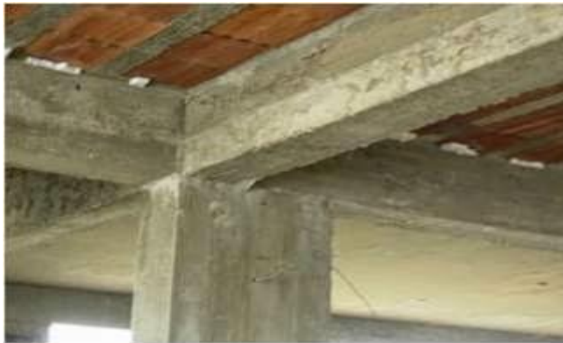
Figura 6. Viga de Concreto armado
