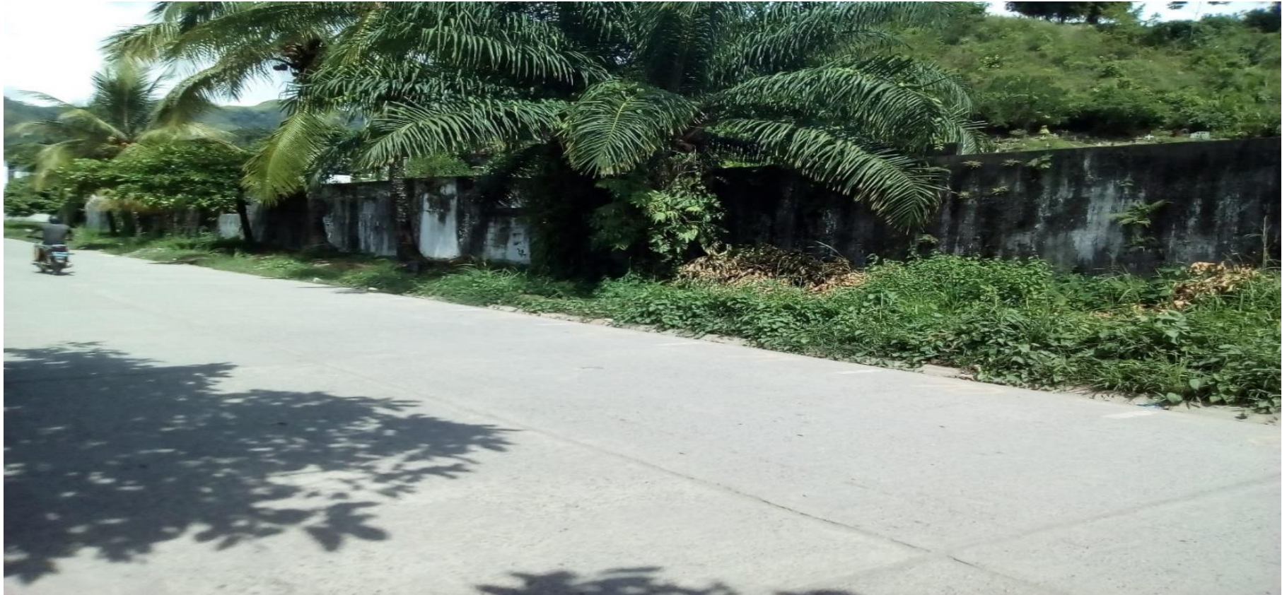
VISTA LATERAL DEL CERCO PERIMÉTRICO DEL CEMENTERIO MUNICIPAL DISTRITO RUPA RUPA, AV. LOS ÁNGELES CDRA. 01 (LADO IZQUIERDO)
