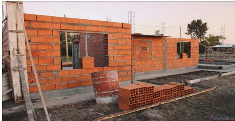
Figura 2 Albañilería Simple Nota. Fuente: (Pérez J. 2004) 9
