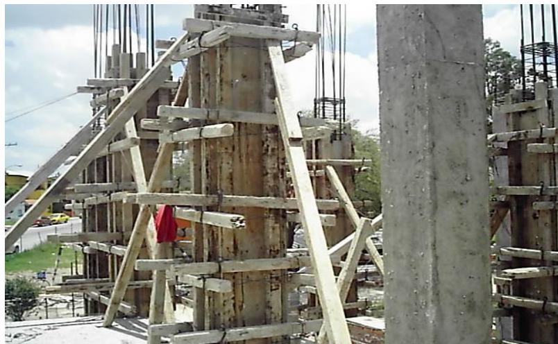
Figura 5.Columnas de concreto armado
