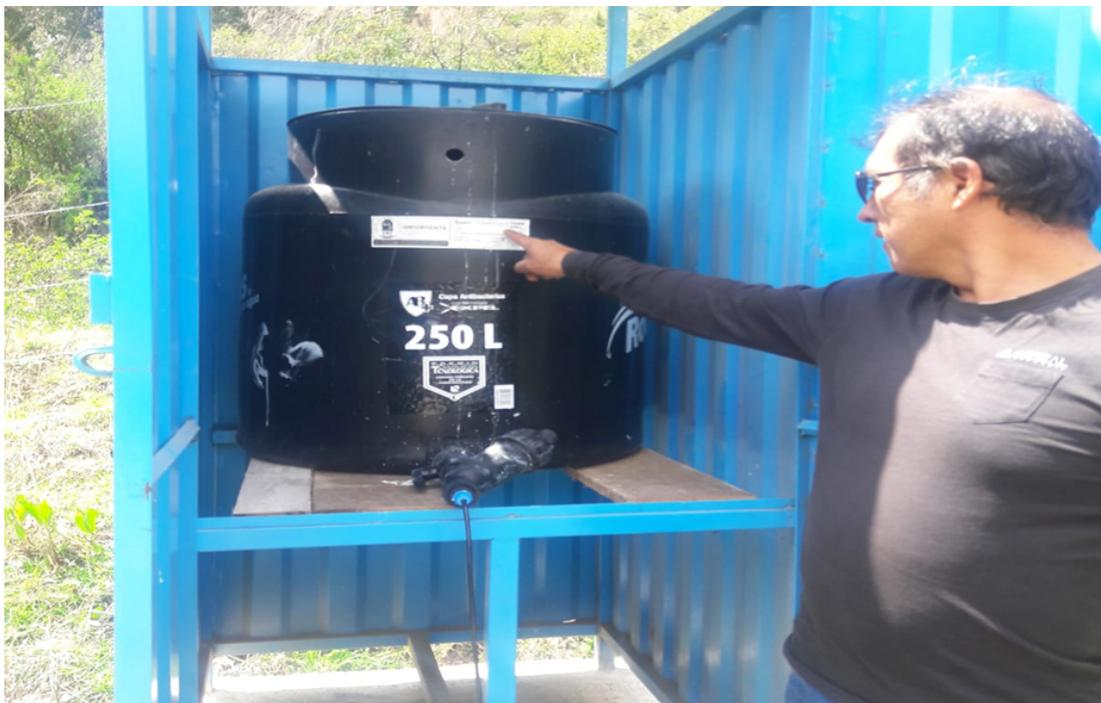
Figura 2.9: Tanque Rotoplas que hace a la vez de cámara de cloración para un conjunto de viviendas.
