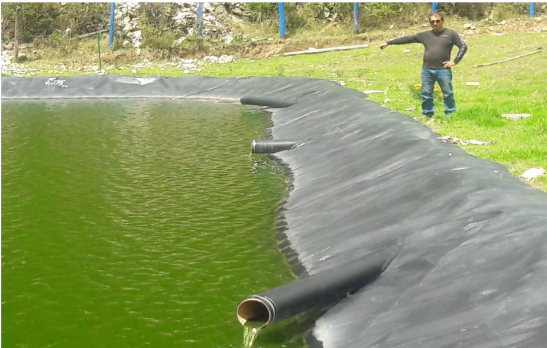
Figura 2.5: Red de colectores que desembocan en la PTAR.
