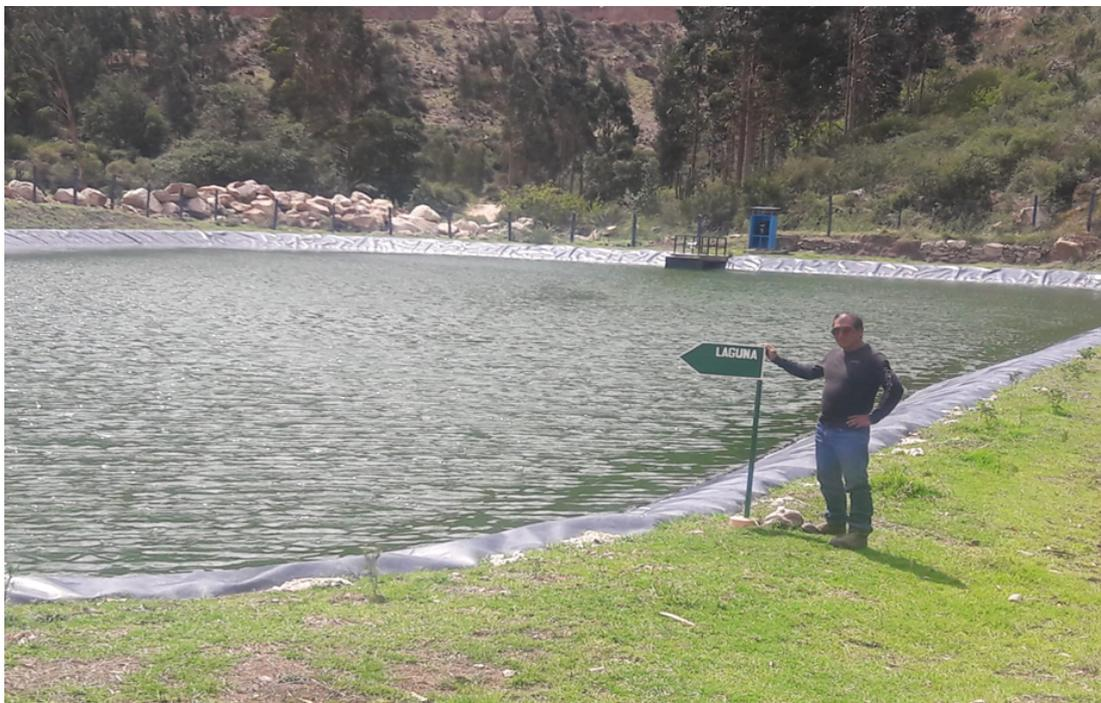
Figura 2.3: Laguna, componente de la PTAR.
