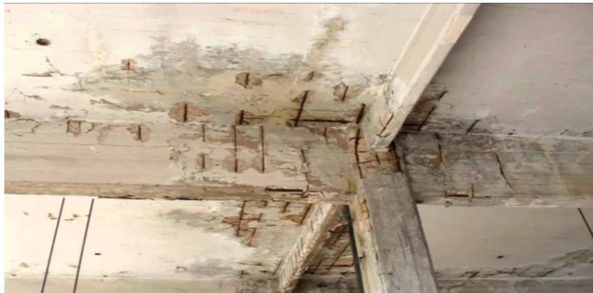
Figura 12. Corrosión afectando a viga peraltada
