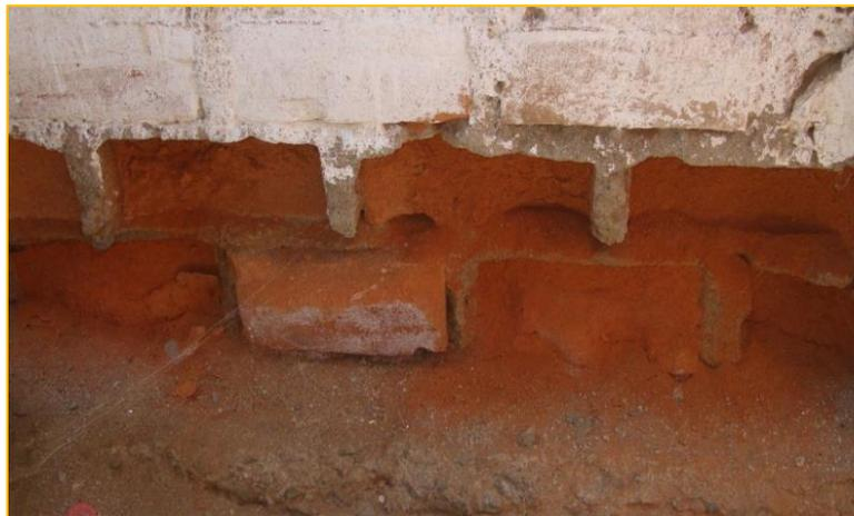
Figura 15. Erosión en muro de albañilería
