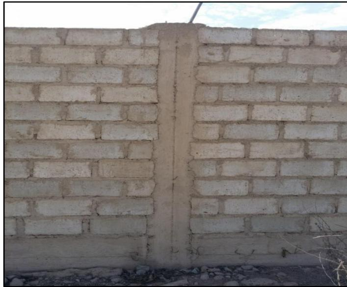
Figura 5. Columna de Concreto armado
