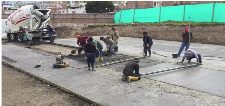
Figura 10. Concreto simple
