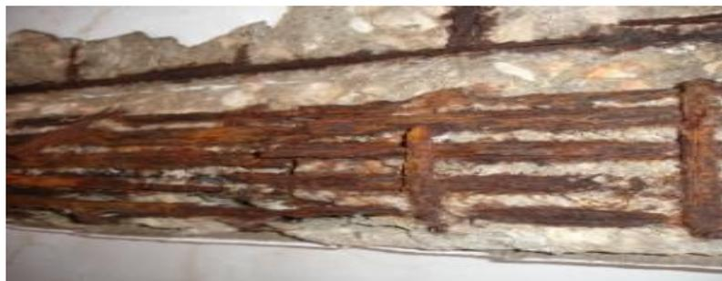
Figura 17. Corrosión del acero en viga
