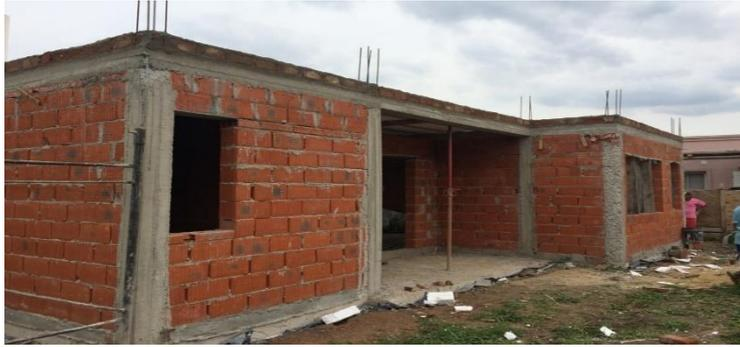
Figura 7. Muro de confinamiento – muros portantes
