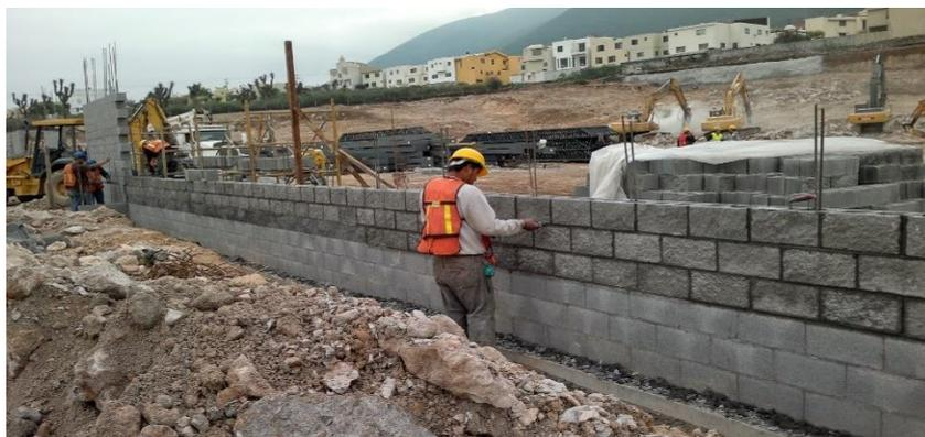
Figura 3. Albañilería Armada
