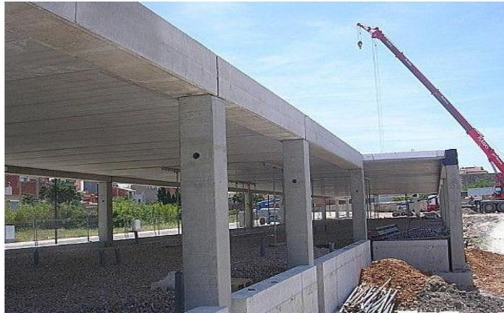
Figura 6. Vigas de concreto armado
