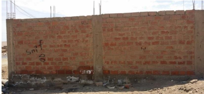
Figura 4. Albañilería Confinada
