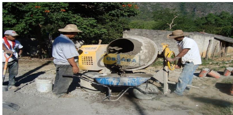
Figura 8. Concreto Simple Nota. Fuente: (Dionisio J. 2015) 19
