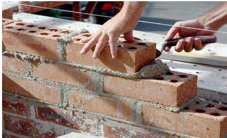
Figura 1. Asentado de albañilería simple Nota. Fuente: (Ramírez M. 2011) 9
