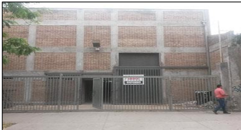
Figura 3. Albañilería confinada o reforzada Nota. Fuente: (Guipúzcoa I. 2011) 10
