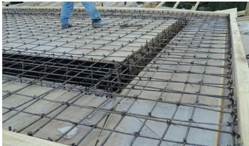
Figura 9. Concreto Armado Nota. Fuente: (Mc Cormac J. 2011) 20
