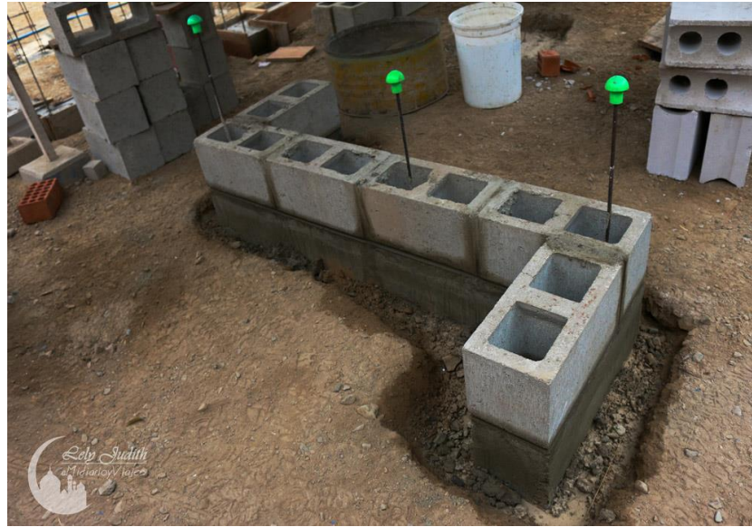
Figura 2. Albañilería Armada Nota. Fuente: (Guipúzcoa I. 2011) 10
